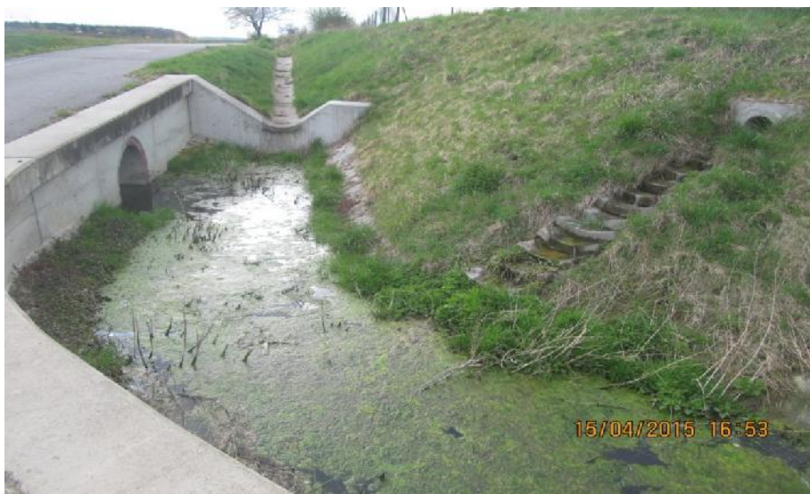
Obr.12 Zaúst ní drenáže do meliora ního odpadu Choovice (autor)
