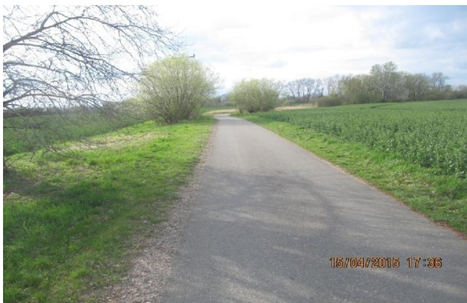
Obr. 18 Polní cesta Kanín C10 po rekonstrukci (autor)
