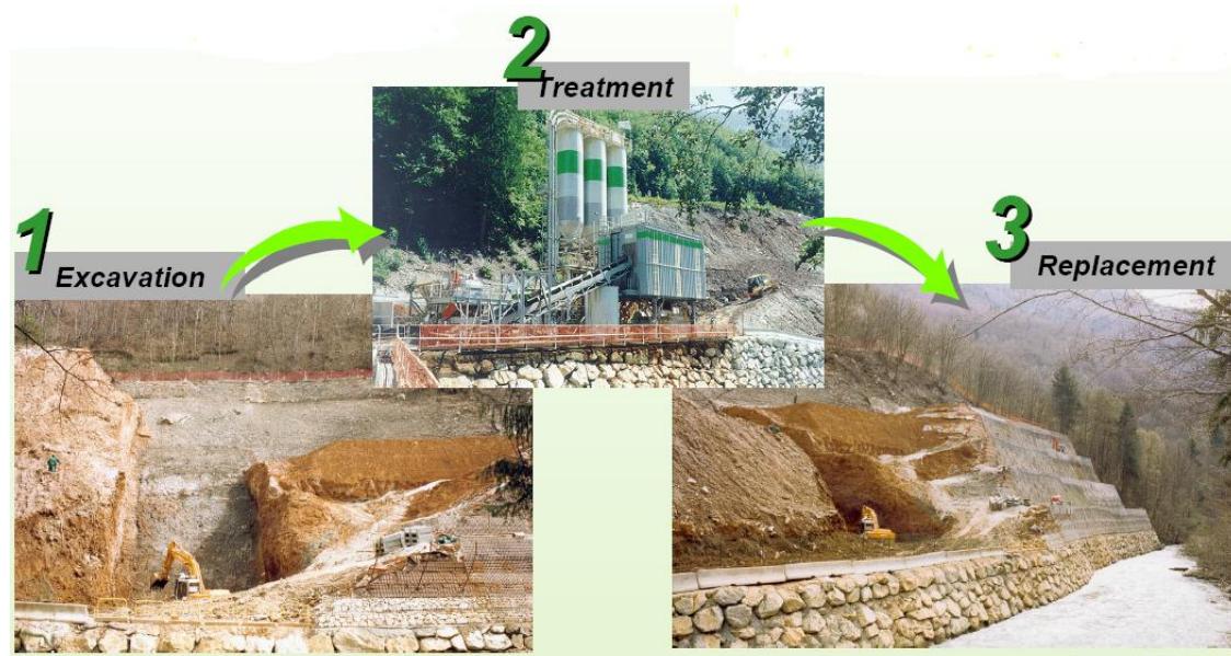
Obrázek č. 5 Jednotlivé fáze sanace skládky pomocí technologie S/S [12]
