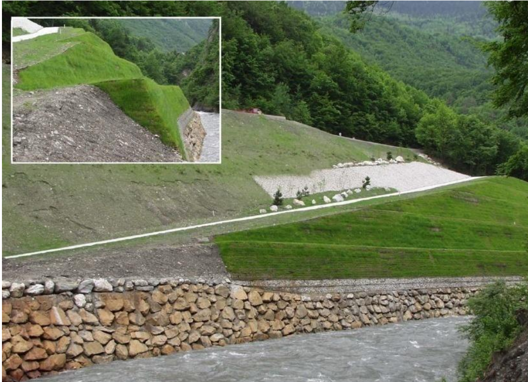
Obrázek č. 7 Dokončená sanace skládky nebezpečného odpadu [13]
