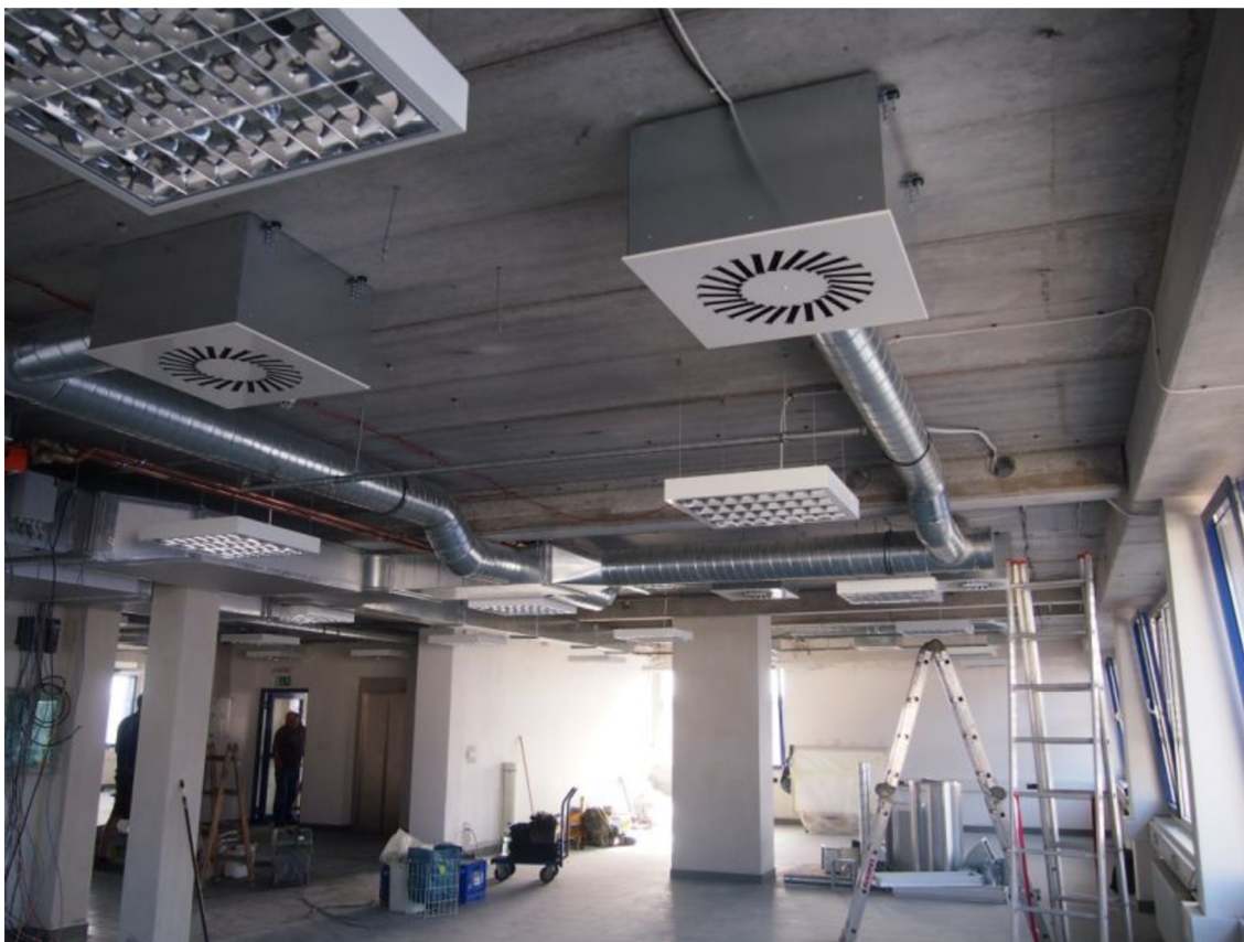
Obrázek č. 3: Realizace vzduchotechniky společností Faksa-Straka, s. r. o. (Zdroj: 2).
