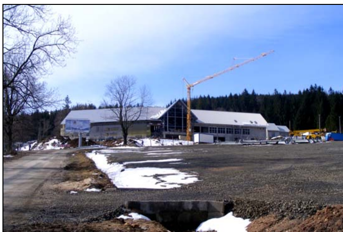
Obr. 52: Stavba budovy koncové stanice kabinkové lanovky (Polsko, Swieradów Zdroj).
