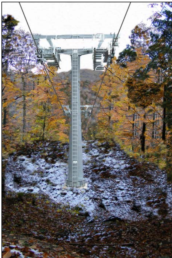
Obr.40 a 41: Křižení trati lanovky u Libverdského mostu.
