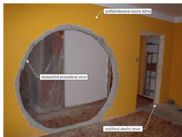
Obr. 2.8 Dodatečný otvor v panelovém domě [3]
