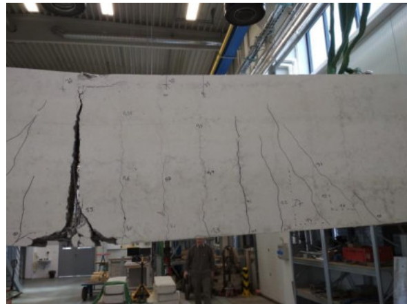
Obr. 6.66 Trhliny v nadpraží – panel S2.II
