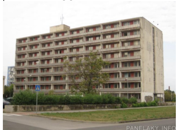
Obr. 2.2 Panelový dům typu T08 B [4]
