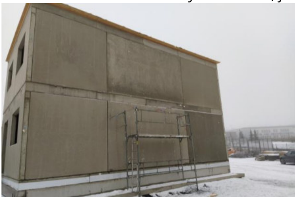
Obr. 6.148 Před vyřezáním otvoru
