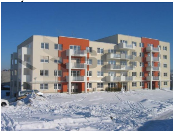
Obr. 2.3 Panelový dům v Jihlavě [5]
