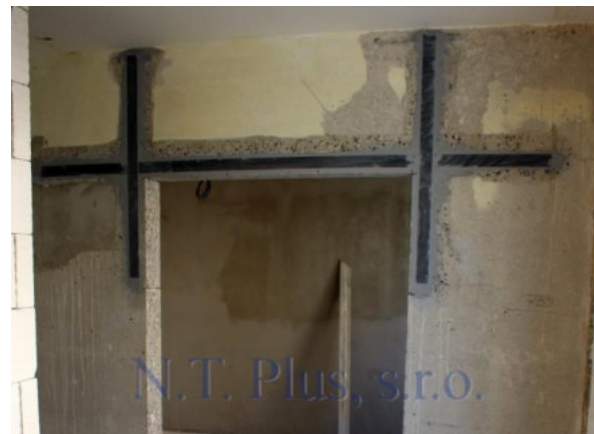
Obr. 2.11 Statické zajištění otvoru uhlíkovými lamelami [11]
