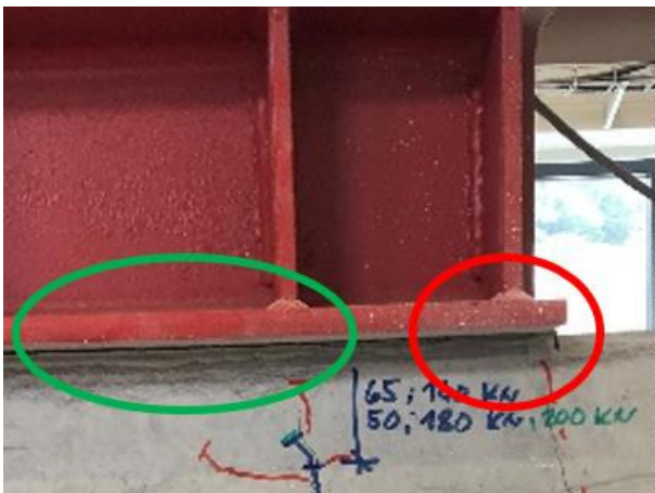
Obr. 6.14 Dokonalé dotlačení nosníku na kraji
