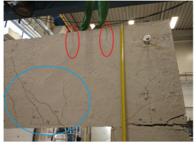
Obr. 6.70 Trhliny v oblasti II – panel S2.I
