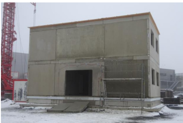
Obr. 6.150 Po vyřezání otvoru
