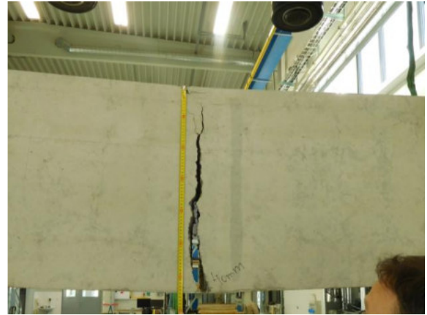
Obr. 6.62 Trhlina uprostřed nadpraží, přerušené výztuže – panel S1.II
