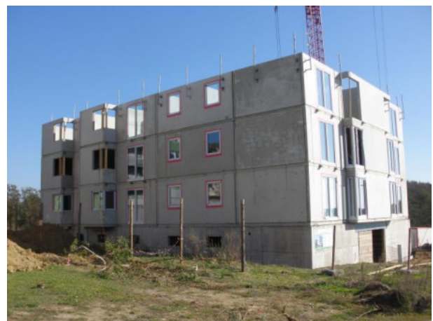
Obr. 2.4 Panelový dům (výstavba) [5]
