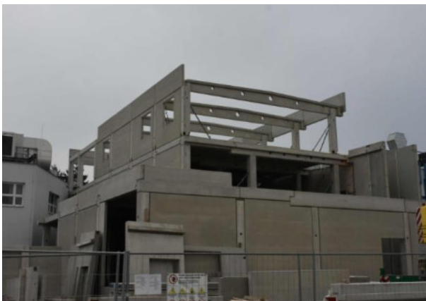
Obr. 2.14 Železobetonový montovaný skelet mlékáren Poděbrady [15]
