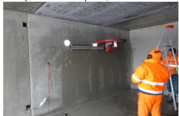
Obr. 6.149 Vřezávání otvoru
