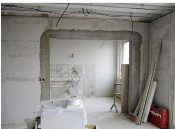
Obr. 2.7 Dodatečný otvor v panelovém domě [2]
