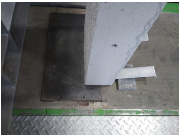
Obr. 6.132 Detail uložení v patě pilíře
