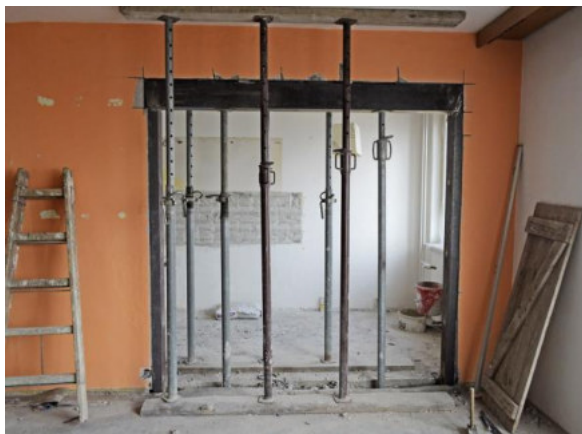
Obr. 2.10 Statické zajištění otvoru ocelovým svařencem [2]
