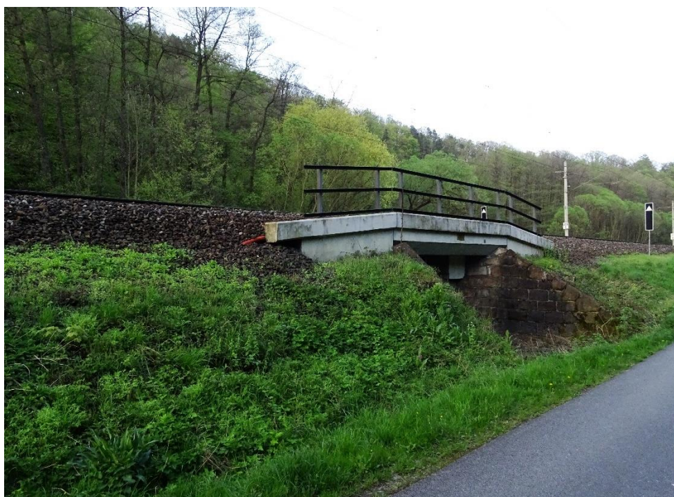
Obr.31: Druhý betonový most v dopravním náspu (zdroj: vlastní)
