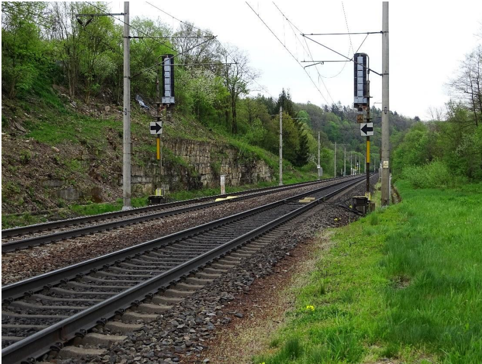
Obr.26: Pohled na druhou část odkopu a vytvořenou sklaní stěnu (zdroj: vlastní)
