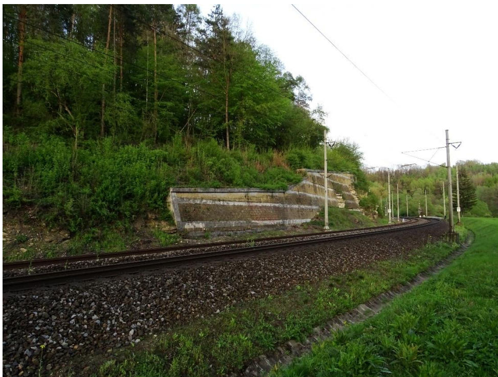
Obr.33: Pohled na svršek a dopravní odkop opatřený zárubní zdí mezi bodem 13 a 14 (zdroj: vlastní)
