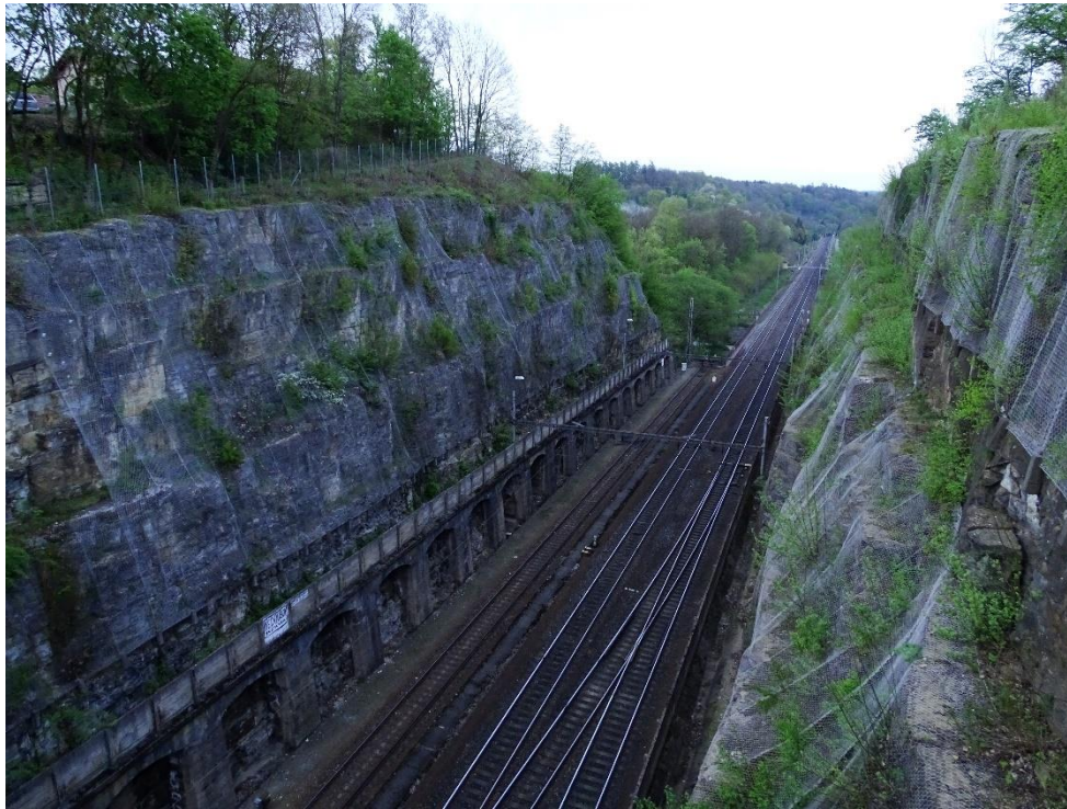
Obr.23: Pohled na dopravní zářez a bod č. 5 z bodu číslo 4 (zdroj: vlastní)
