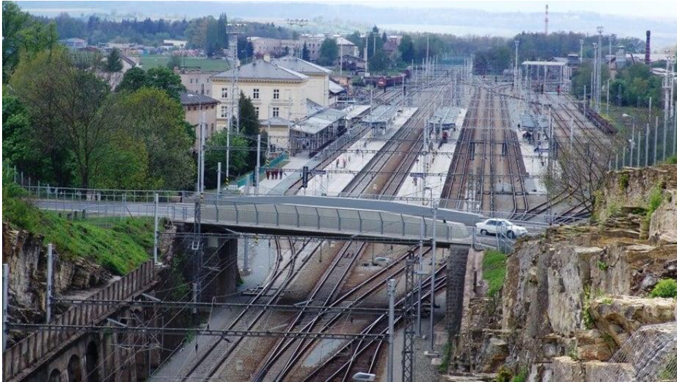
Obr.20: Pohled na zúžení nádraží a most, kde probíhalo měření (zdroj: Skanska, 2005)
