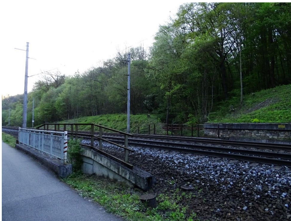
Obr.29: Betonová výpust' (zdroj: vlastní)
