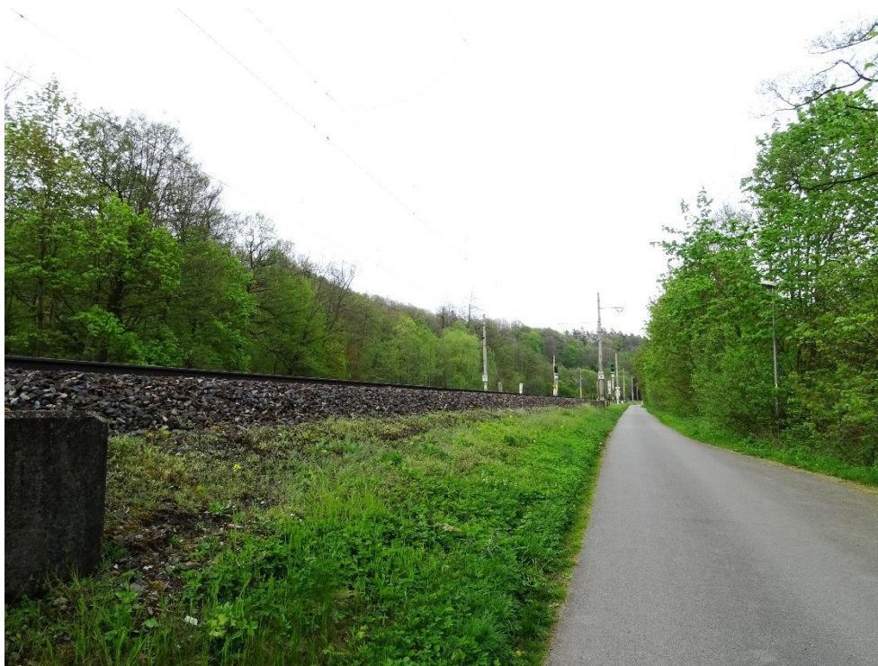
Obr.28: Pohled na dopravní násep (zdroj: vlsatní)
