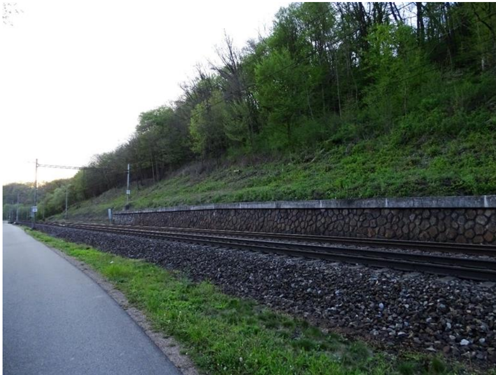
Obr.30: pohled na dopravní odkop s opěrnou zdí (zdroj: vlastní)
