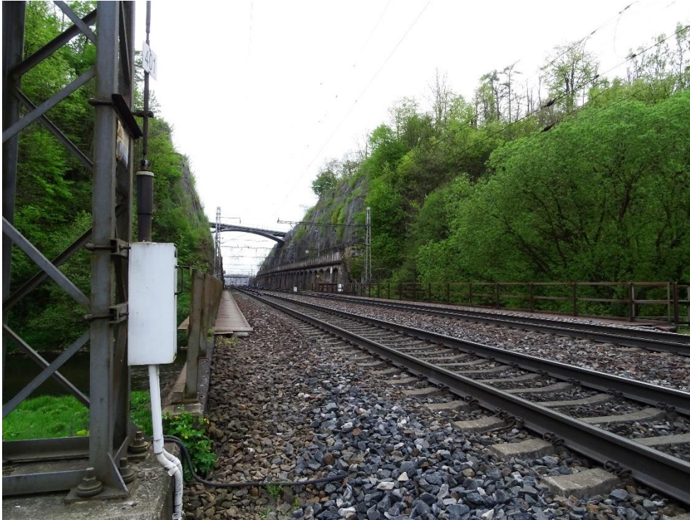
Obr.24: Bod měření číslo 5 a pohled na most (zdroj: vlsatní)
