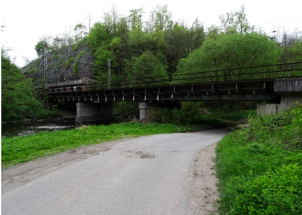
Příloha č.28 – Železniční most, úsek mezi body č. 5 a 6
