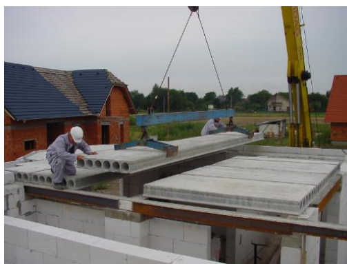
Obr. 9 Realizace stropu z panelů SPIROLL / PARTEK (dwpl.cz, 2014)
