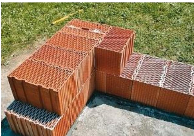
Obr. 4 Zdění z cihelných bloků Heluz STI (HELUZ, 2007)
