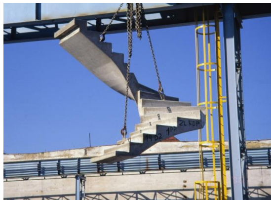
Obr. 12 Příklad betonového prefabrikovaného schodiště (Archiv firmy Liapor, 2008)
