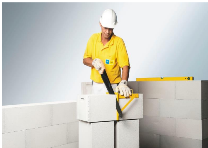
Obr. 5 Zdění z přesných tvárnic Ytong (ArchiExpo, 2008)
