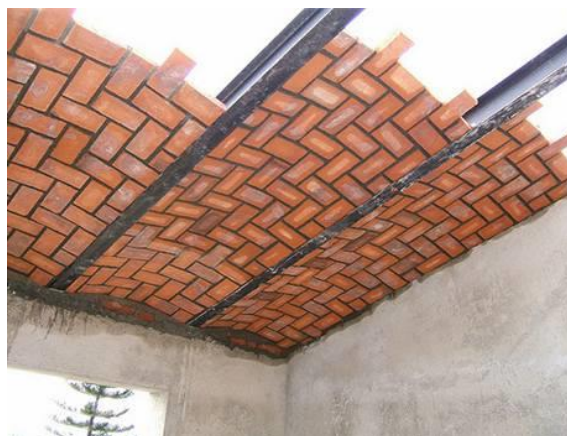
Obr. 6 Realizace přímé klenby (Bydlení idnes, 2009)
