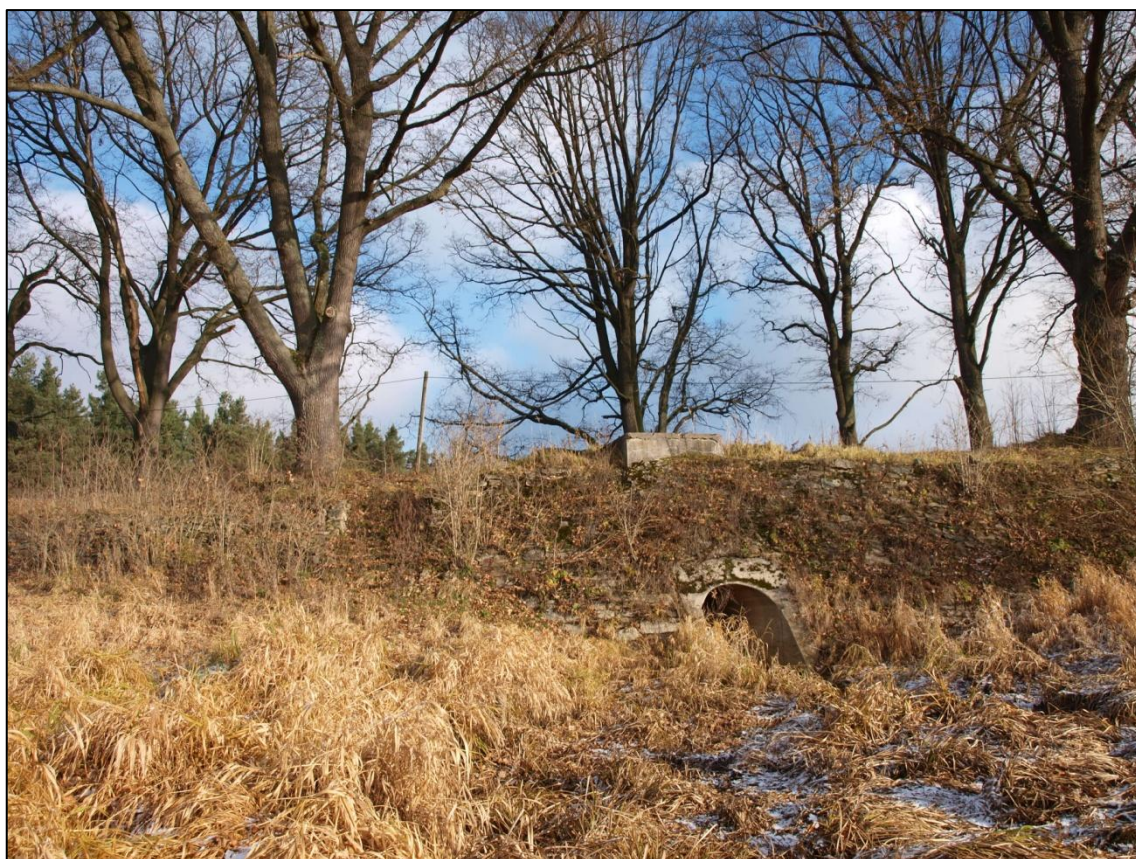
Obr. 12 Klenutá kamenná výpust' Blatského rybníku (Marie Bartošková, 1. 12. 2012)
