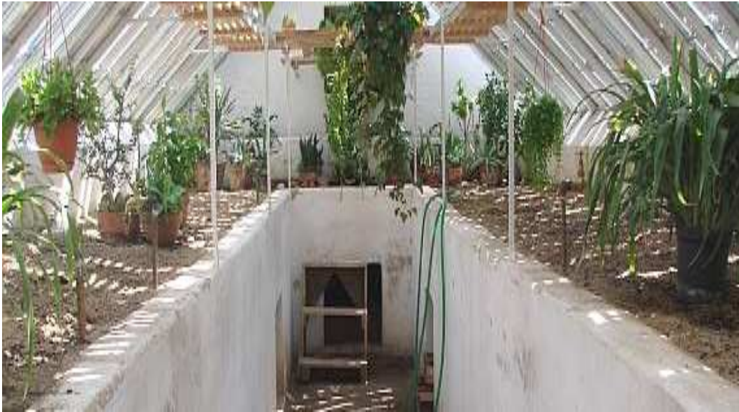
Obrázek 8: Skleníků se zachovalým kanálovým topením na zámku Veltrusy
