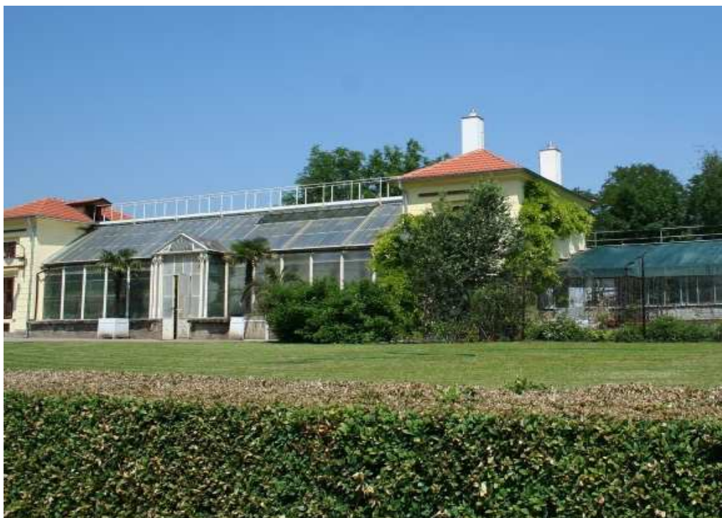
Obrázek 5: Palmový skleník a vpravo část sbírkového skleníku v Libochovicích
