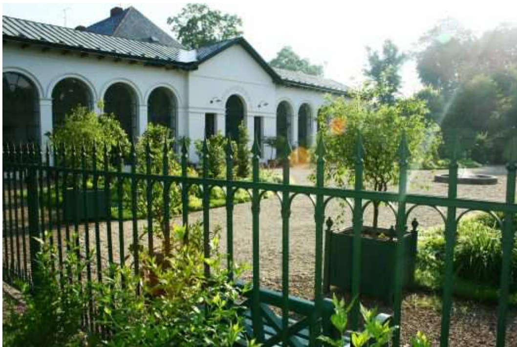
Obrázek 2: Oranžerie na zámku Raduň po rekonstrukci
