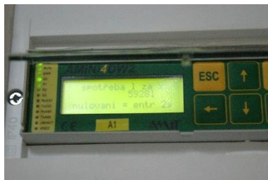
Obr. 5: Zobrazení kumulovaného průtoku systém MaR
