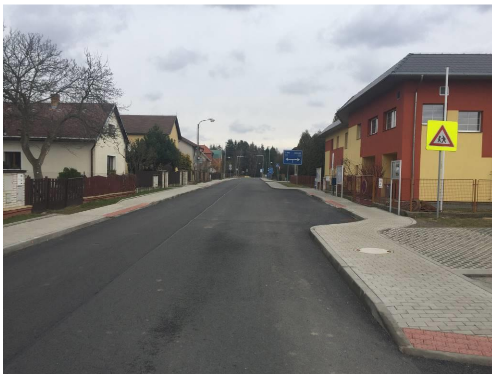
Foto 7: Modernizovaná silnice u Obecního úřadu
