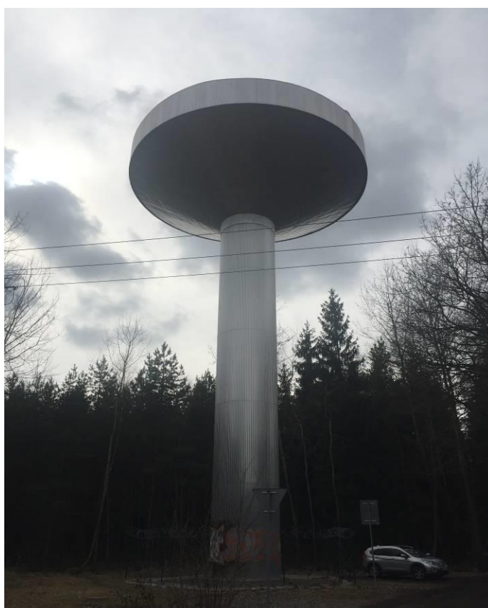
Foto 9: Vodovod v obci Struhařov
