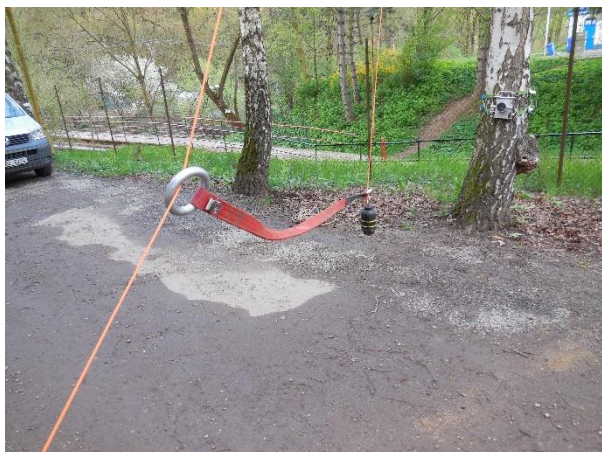
Obrázek 32 Instalace chrániče kambia do koruny stromu
