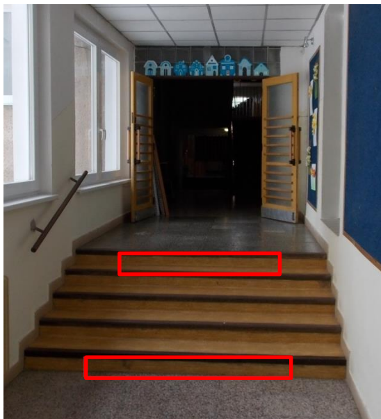
Obr. č. 43 Schodiště v 1NP při přechodu ze staré do nové budovy
