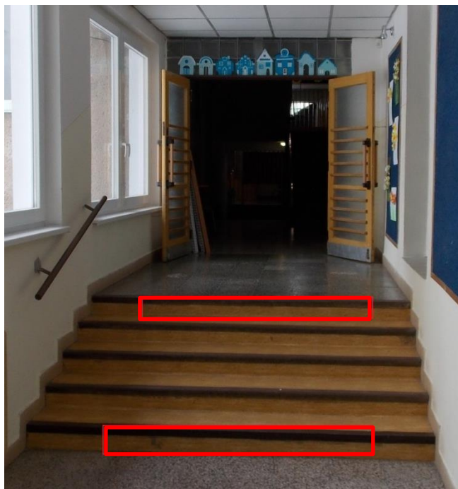
Obr. č. 72 Vyrovňovací schodiště v 1NP mezi novou a starou budovou
