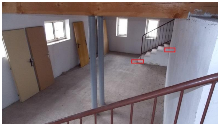
Obr. č. 62 Pohled na bývalá schodiště 4NP
