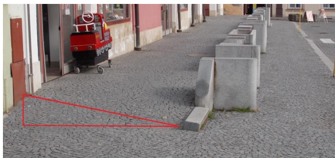
Obrázek č. 2 Nájezdová rampa (levá strana)
