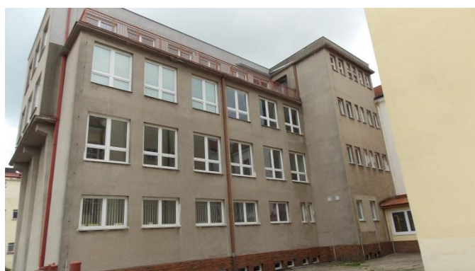
Obr. č. 25 Nová budova (pohled ze dvora)
