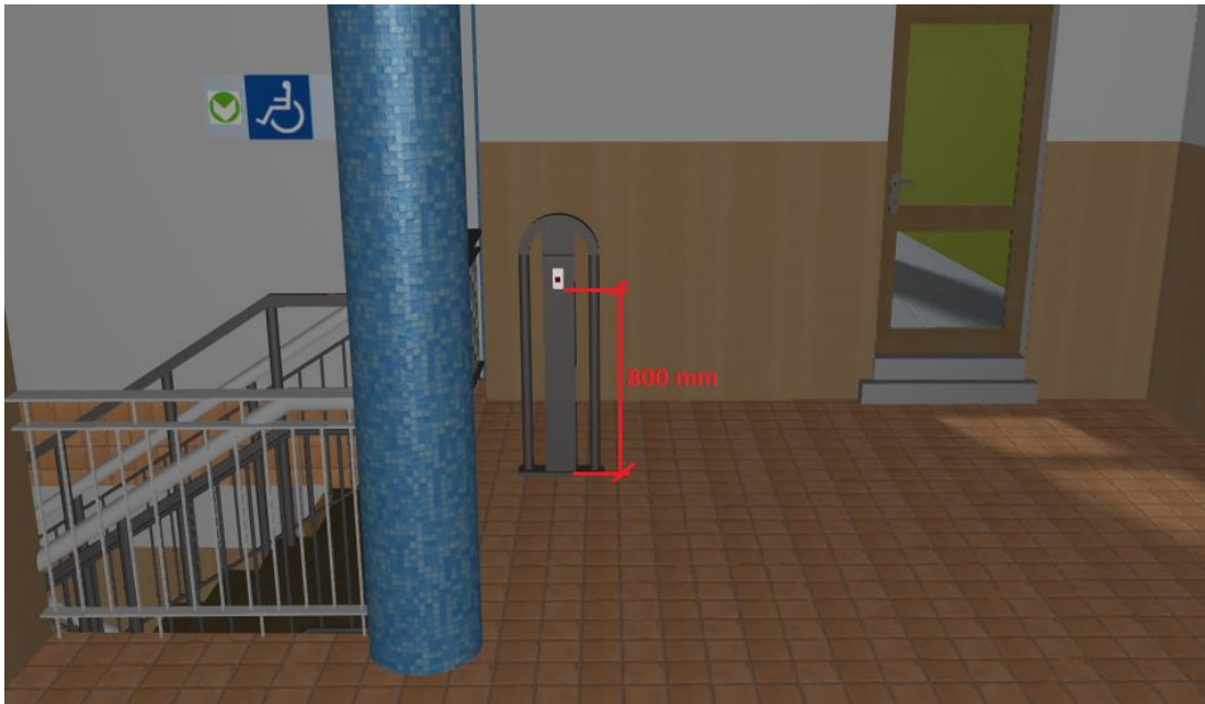
Obr. č. 81 Šikmá schodišťová plošina CPM 300 ve 4NP
