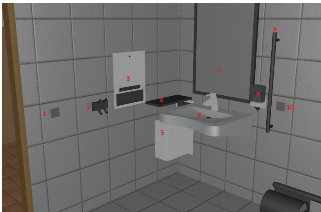
Obr. č. 84 Vybavení hygienického zařízení ve 3NP
