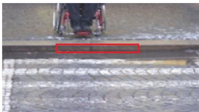
Obrázek č. 5 Řešení chodníku (výškový rozdíl 25mm)
