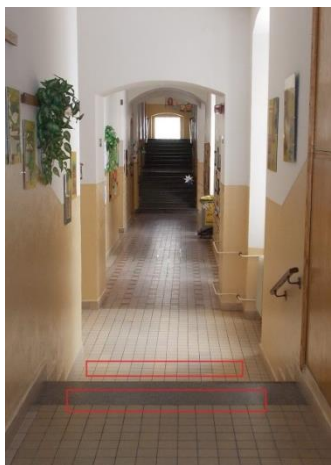
Obr. č. 47 Vyrovnávací schodiště 2NP
