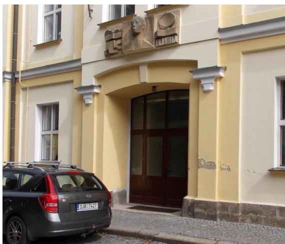
Obr. č. 29 Vstup do staré části budovy
