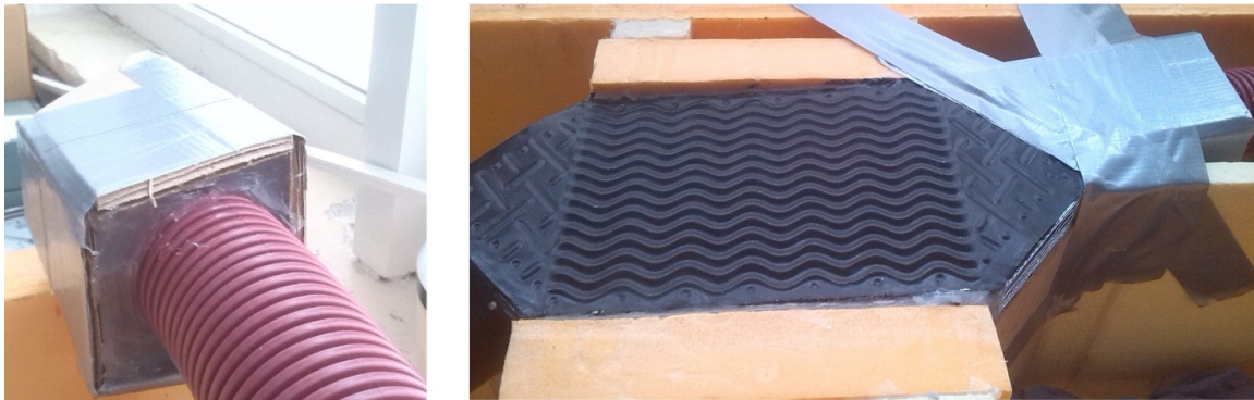
Obrázek 8: Výroba a zabudování příruby pro přívod vzduchu do výměníku
