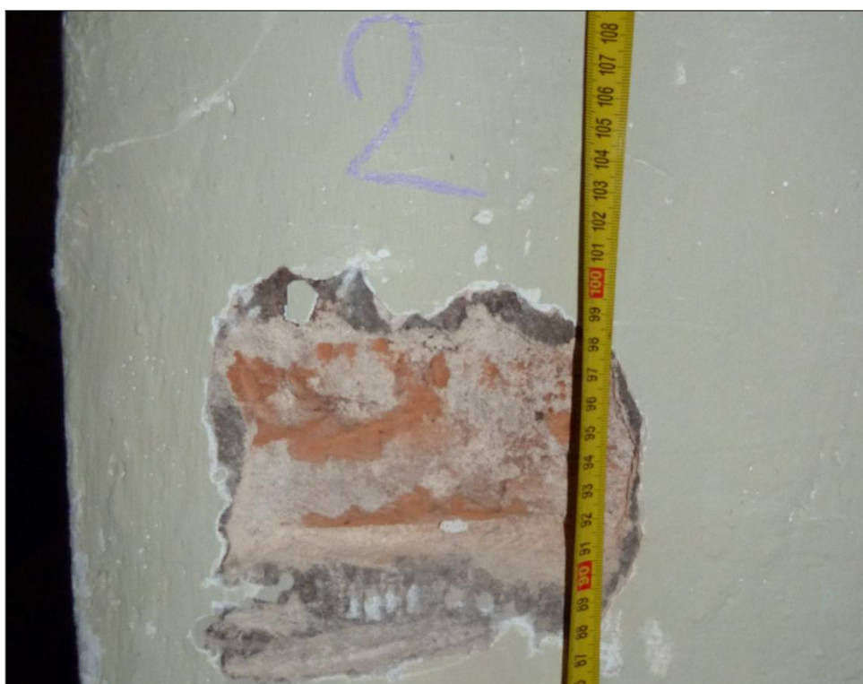
Obrázek 4.4.1-1 Sonda S2 v 1. NP v místě klenebního pilíře na rozhraní dvou materiálů – pískovcových kvádrů a pálených cihel. Svinovací metr ukazuje rozhraní těchto materiálů ve výšce od úrovně podlahy. [41]
