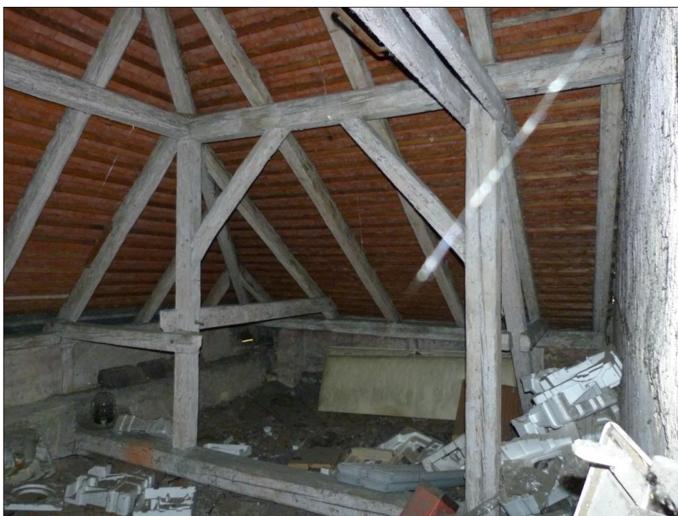
Obrázek 4.2.3-2 Jediná část objektu (východní část), kde nebyla vybudována půdní vestavba a kde je dobře patrná konstrukce krovu [41]
