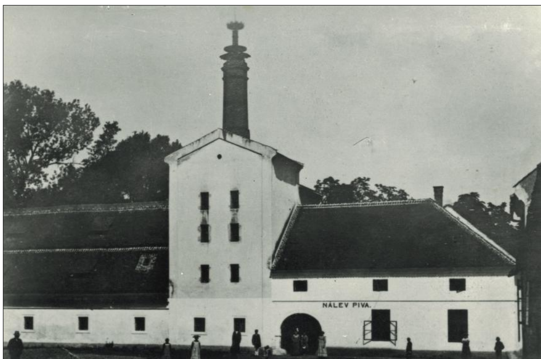
Obrázek 4.2.1-3 Budova panského pivovaru ve Zlíně po přístavbě věže s komínem kolem roku 1905. Nástavba objektu byla provedena také v pravé části budovy od věže [26]
