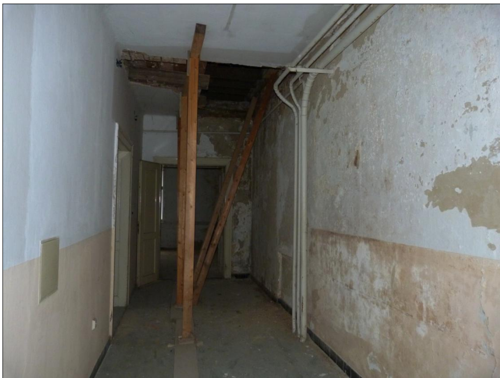
Obrázek 4.3-10 Provizorní podepření zbylé dřevěné trémové konstrukce stropu nad 3. NP v místě vyřezání nejpoškozenějších částí této konstrukce z důvodu zatékání vody na styku původní budovy a nedokončené přístavby z roku 1997. [41]
