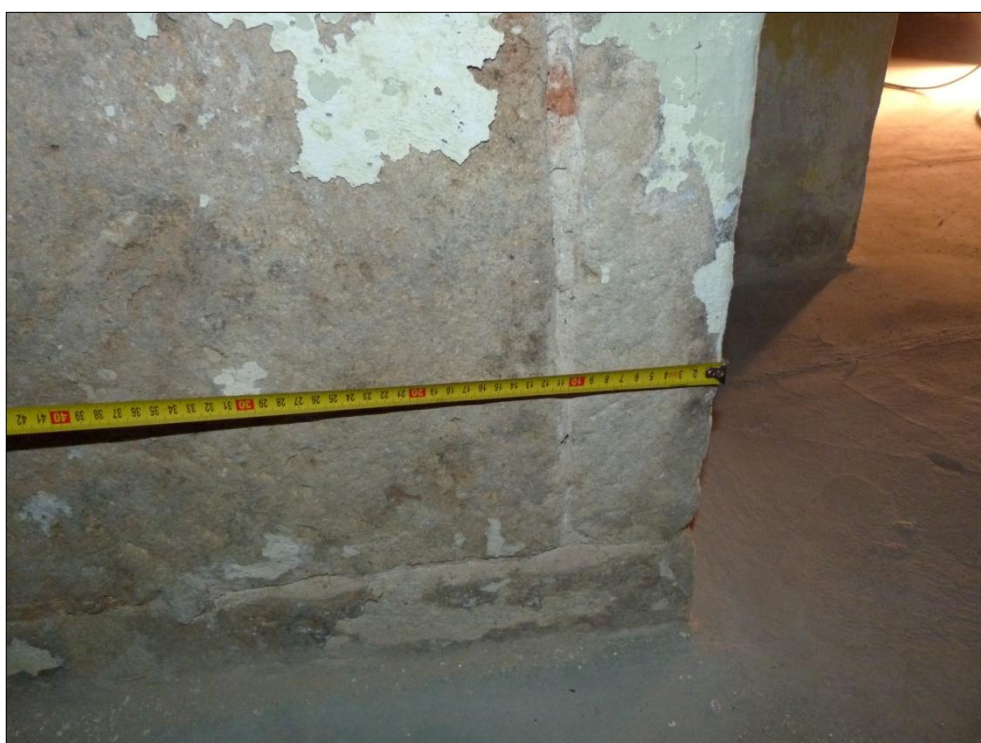
Obrázek 4.4.1-5 Detail precizně opracovaných pískovcových kvádrů na klenebním pilíři uvnitř dispozice 1.NP [41]
