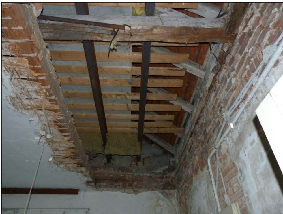
Obrázek 4.3-9 Pohled na vyřezanou stropní konstrukci nad 3. NP [41]
