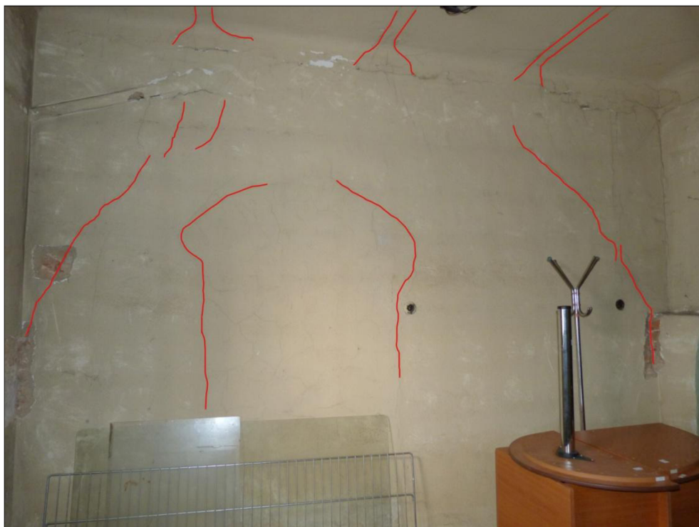
Obrázek 4.3-2 Prokopírované drobné trhliny ukazují, že původní otevřený klenbový prostor byl dodatečně zazděn a byl v něm zanechán pouze otvor pro dveře, který byl opět v další stavební fázi zazděn. Na novějším železobetonovém stropě lze vidět prokopírované trhliny od ocelových profilů a roznosu zatížení. [41]
