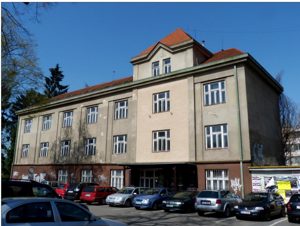
Obrázek 4.1-1 Budova bývalého soudu ve Zlíně [41]
