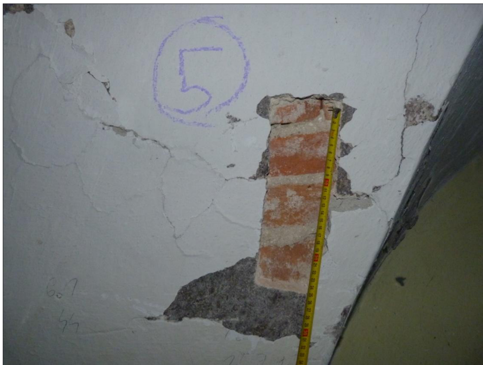
Obrázek 4.4.3-1 Sekaná sonda S5 na křížové klenbě nad 1. NP. Zdivo je z plných pálených cihel zděných na vápennou maltu [41]
