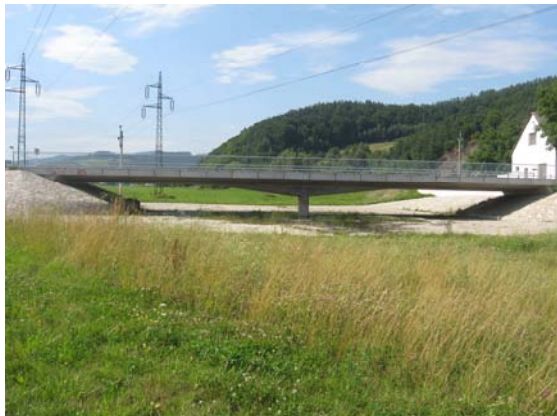
Foto 8: Inundační most v obci Bohutín. (P. Janků, září 2008)
