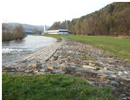
Foto 11: Upravené koryto řeky pod areálem OP s výlevem do přilehlého poldru. (P. Janků, 11.4. 2009)
