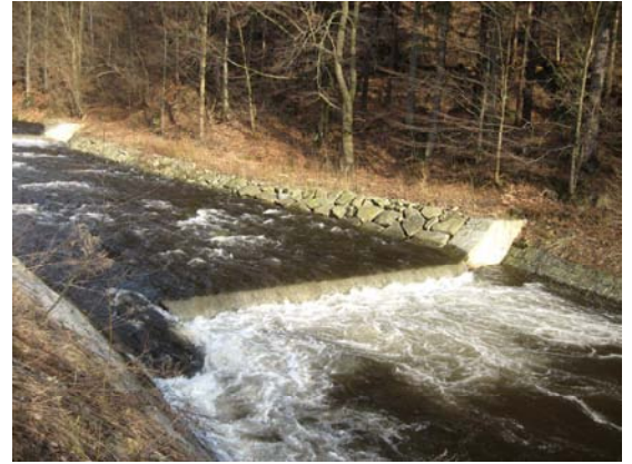
Foto 27: Zde jsou vidět 2 stupně za sebou pod soutokem řek, upravené koryto zčásti betonovou zídka a lomovými kameny. (P. Janků, 6.4. 2009)
