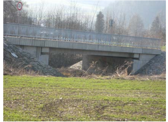
Foto 6: Inundační most Bartoňov (protipovodňová ochrana Rudy n./Mor.). (P. Janků, 5.4. 2009)
