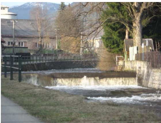
Foto 34: Jez Loučná (Rejhotice) IV, betonové těleso jezu, opěrné zdi jsou z lomového kamene. (P. Janků, 6.4. 2009)
