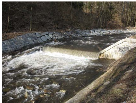
Foto 23: Stupeň na řece Divoká Desná a opevněné svahy původní dlažbou. (P. Janků, 6.4. 2009)
