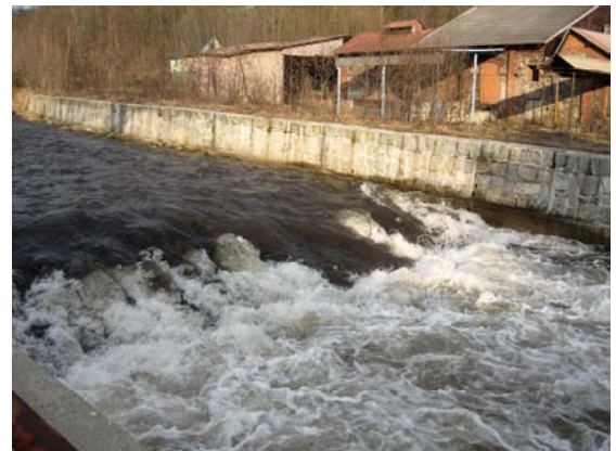
Foto 29: Opěrná zeď v Loučné nad Desnou (Rejchartice). (P. Janků, 6.4. 2009)
