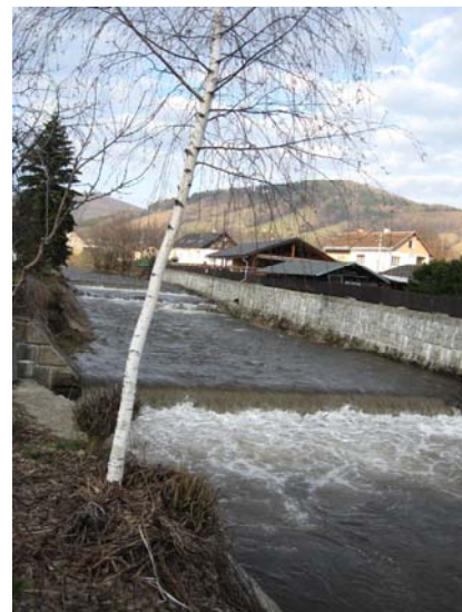
Foto 33: Stupňová kaskáda v obci Loučná nad Desnou – Rejhotice. Koryto je zpevněno betonovou zídka a kamennými kvádry. (P. Janků, 6.4. 2009)
