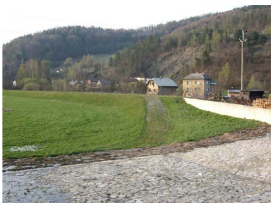
Foto 10: Levobřežní odsazená zeď a hráz. (P. Janků, 11.4. 2009)
