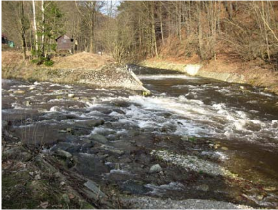
Foto 24: Upravené koryto na soutoku Divoké a Hučivé Desné, v pozadí je vidět stupeň na řece Divoká Desná. (P. Janků, 6.4. 2009)
