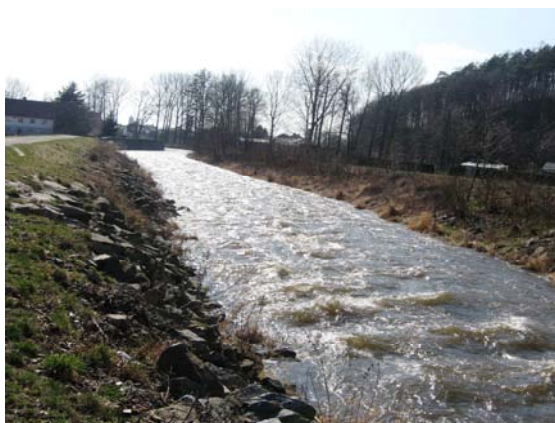
Foto 16: Pohled od silničního mostu Šumperk – Hraběšice na ochrannou hráz. (P. Janků, 5.4. 2009)
