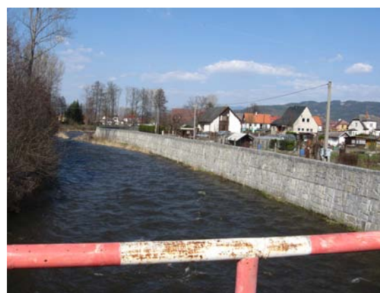
Foto 17: Levobřežní ochranná zeď, chránící místní zástavbu a zahrady. (P. Janků, 5.4. 2009)
