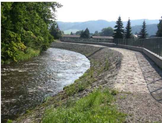
Foto 3: Podél koupaliště v Rudě n/Mor. je pravý břeh odlážděn, hráz je nahrazena betonovou zítkou. (P. Janků, 5.4. 2009)
