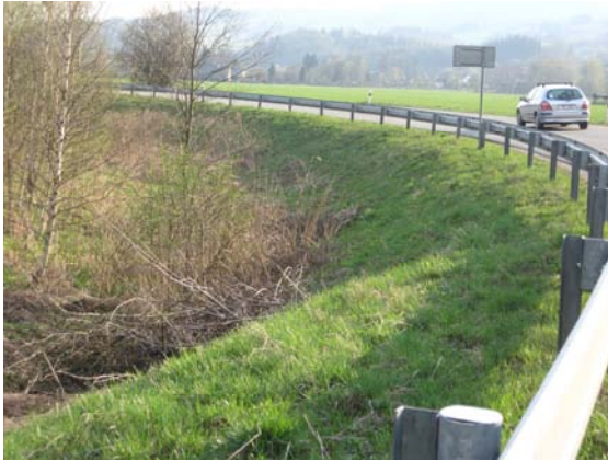
Foto 1: Pravobřežní inundace (zvýšena úroveň a rekonstrukce stávající silnice v Raškově – ochrana pravobřežní zástavby obce). (P. Janků, září 2008)
