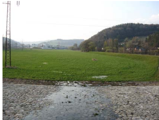
Foto 9: Pohled na udržovaný poldr nad inundačním mostem. (P. Janků, 11.4. 2009)
