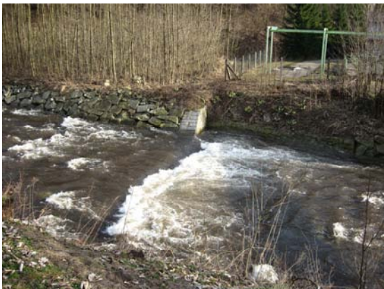
Foto 28: Spádový stupeň před úpravou vody v Koutech nad Desnou. (P. Janků, 6.4. 2009)
