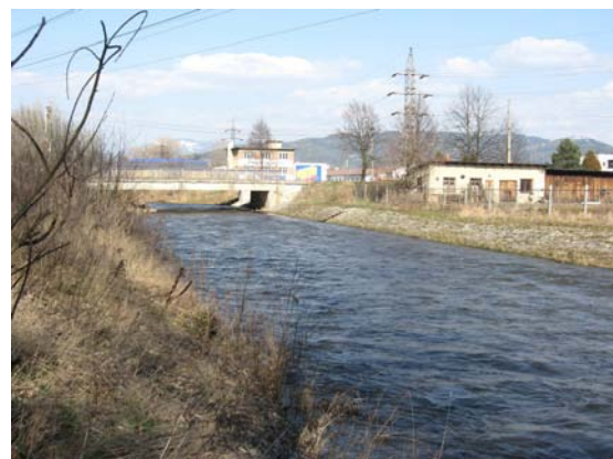
Foto 15: Pohled proti směru toku, silniční most Šumperk – Plechy (koryto je opevněno dlažbou). (P. Janků, 5.4. 2009)
