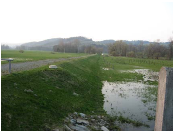
Foto 12: Pravobřežní hráz končící u ochranné zdi a silnice (Chromeč – Šumperk). (P. Janků, 11.4. 2009)
