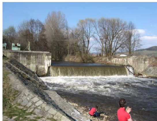
Foto 19: Kremišovský jez s opravenými opěrnými křídly. (P. Janků, 5.4. 2009)
