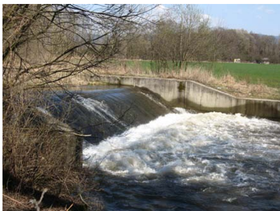
Foto 14: Jez u závodu Moravolen Šumperk se zpevněnými břehy. (P. Janků, 5.4. 2009)
