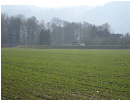
Foto 7: Vybudovaná pravobřežní odsazená hráz navazující na místní komunikaci. (P. Janků, 5.4. 2009)
