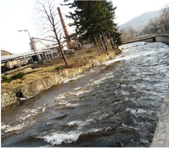
Foto 30: Opěrné zdi podél silniční komunikace a podél areálu dřevařské firmy v Loučném nad Desnou (Rejhotice). (P. Janků, 6.4. 2009)
