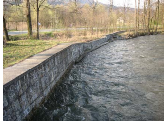
Foto 2: Pohled z mostu na Moravu (snížená pravobřežní zeď). (P. Janků, září 2008)
