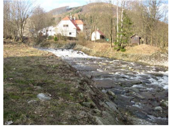
Foto 25: Spádový stupeň na přítoku Hučivé Desné, svahy koryta jsou pouze zpevněny kamennou dlažbou. (P. Janků, 6.4. 2009)
