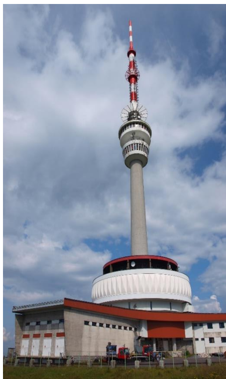
Obr. 40: Vysílač na nejvyšší moravské hoře Pradědu nahradil zřícenou kamennou rozhlednu i Poštovní chatu vybudovanou ve čtyřicátých letech 20. století. (Zdroj: Archiv autora).
