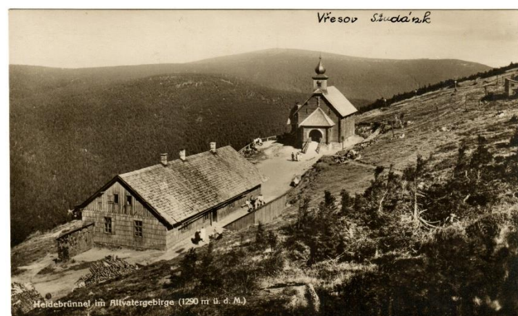
Obr. 13: Chata Vřesová studánka situována na svazích Červeného hory. (Zdroj: Archiv autora)
