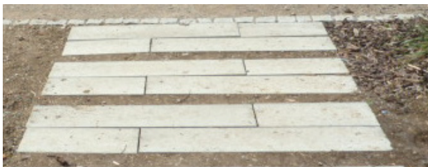
Obr. č. 15 - Cesta z betonových prefabrikátů
