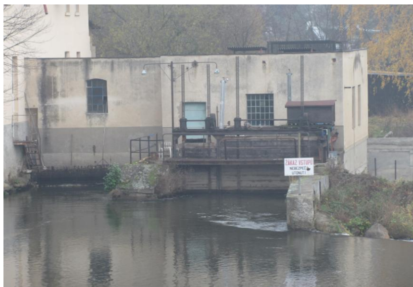
Obr. 15 - Budova MVE Řevnice
