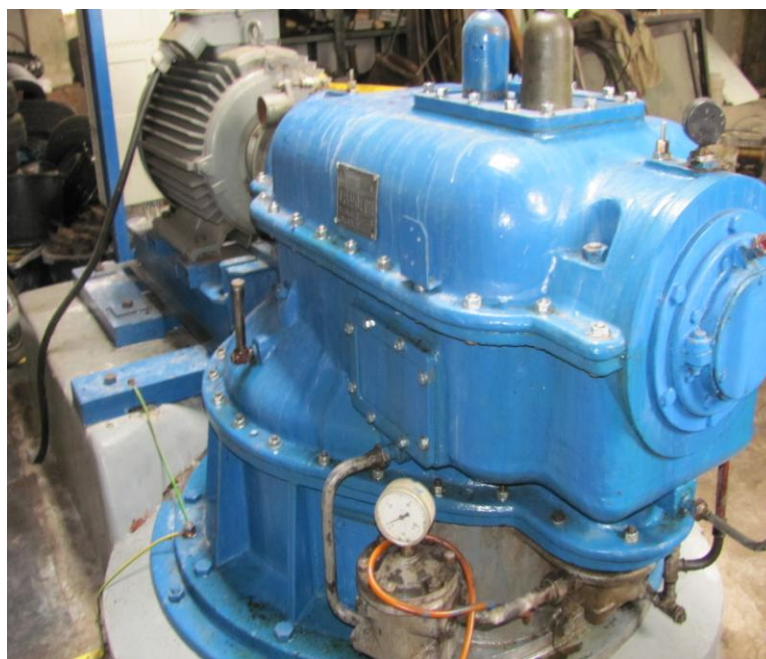
Obr. 18 – Francisova turbína v MVE Řevnice
