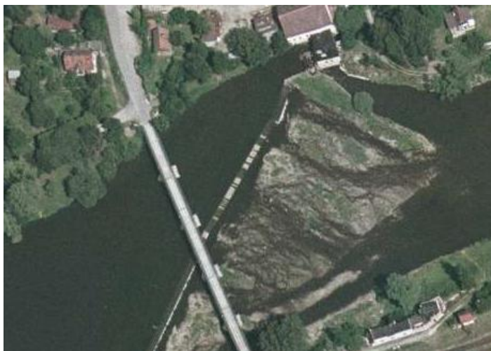
Obr. 14 - Letecký pohled na jez a MVE v Řevnicích
