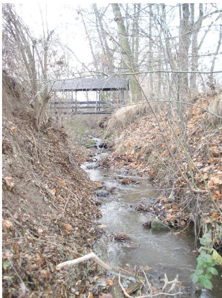
Foto 18 Zhloubené koryto - Lávka – pohled proti směru toku (foto L.Zahradník)
