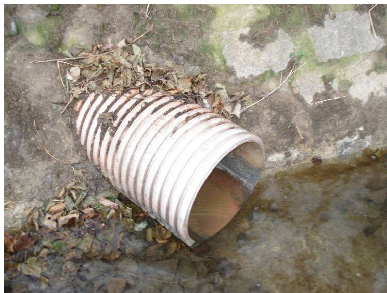
Foto 21 Vyústění drenážního potrubí PVC DN 400 z p.p.č. 211 do recipientu (foto L.Zahradník)
