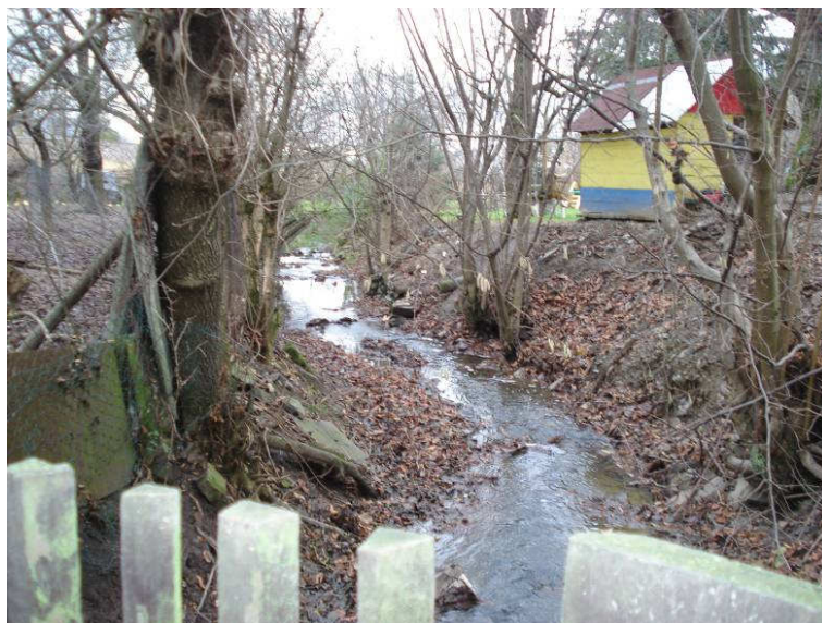
Foto 4 Pohled po toku na začátek zaplaceného úseku (foto L.Zahradník)
