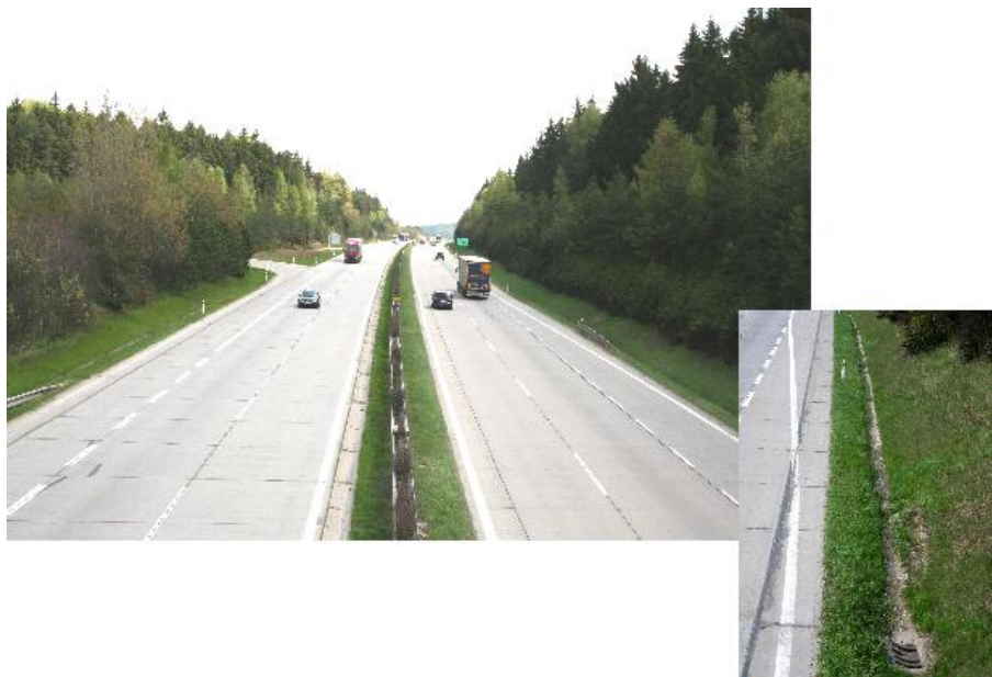
Obr. 3.11 Odchyťová lokalita č. 10 – Větrný Jeníkov (s detailem odvodňovacího příkopu).
