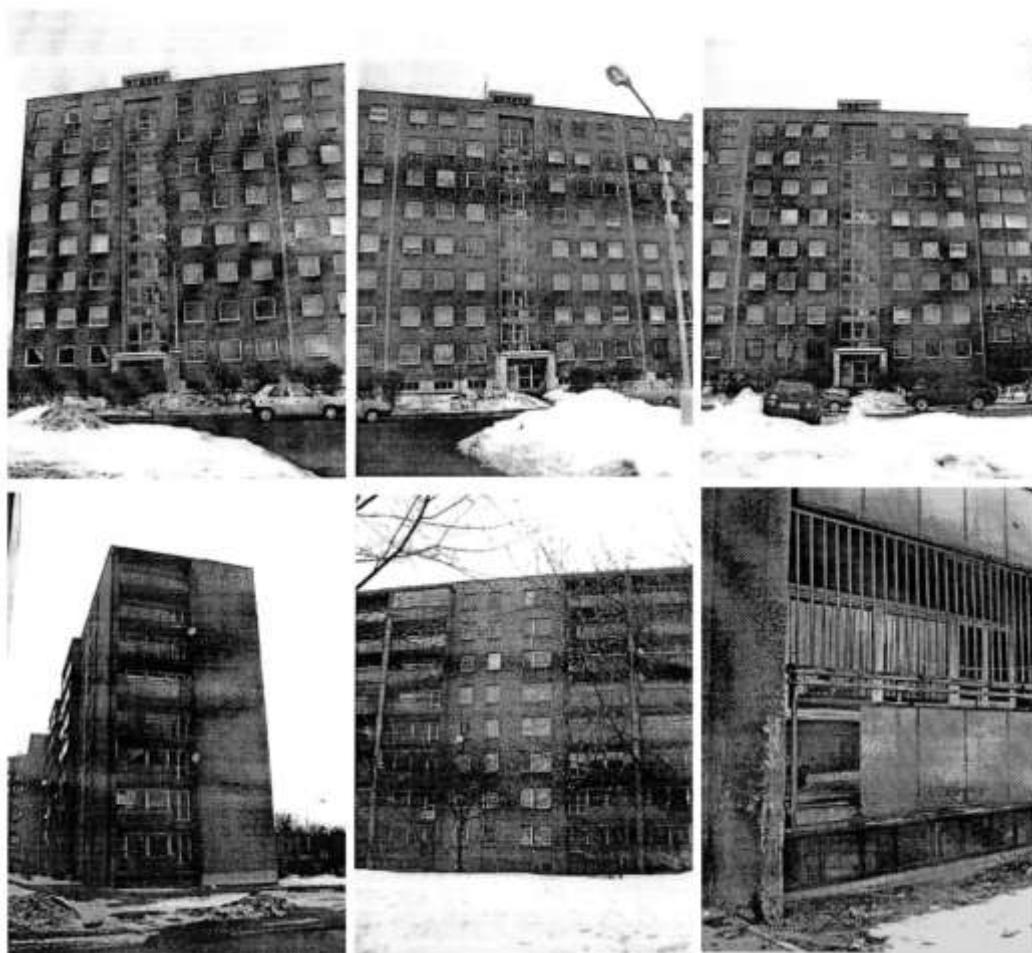
Obr. č. 8 – Panelový bytový komplex před rekonstrukcí
