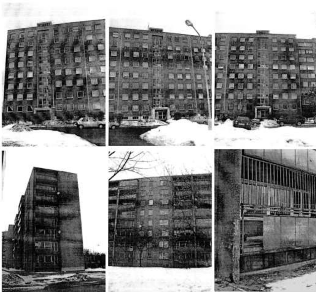
Obr. č. 8 – Panelový bytový komplex před rekonstrukcí
