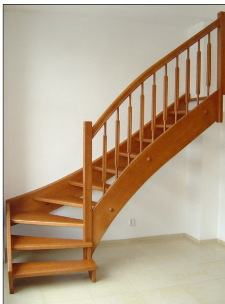
Obr. 5.5 Dřevěné schodiště schodnicové
