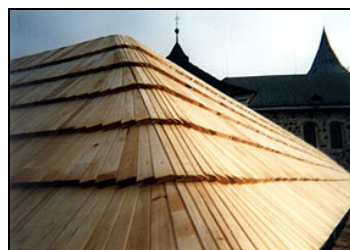
Obr. 5.18 Příklady pokrytí střechy šindelem [36]
