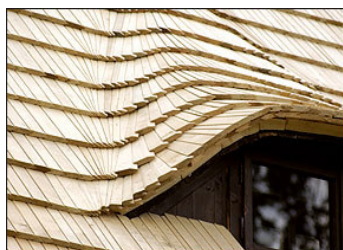
Obr. 5.18 Příklady pokrytí střechy šindelem [36]
