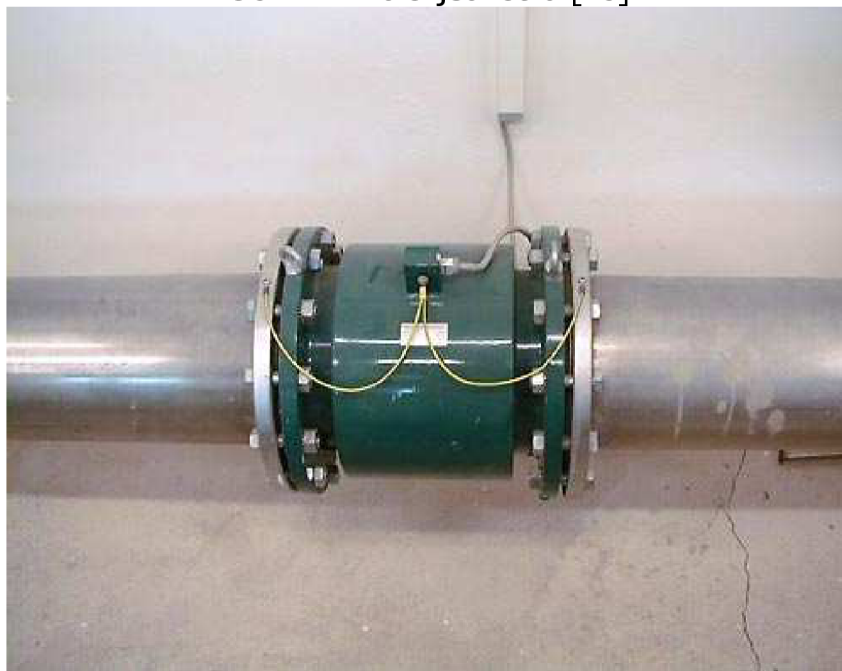
Obr. 4.8 Přírubový snímač [17]
