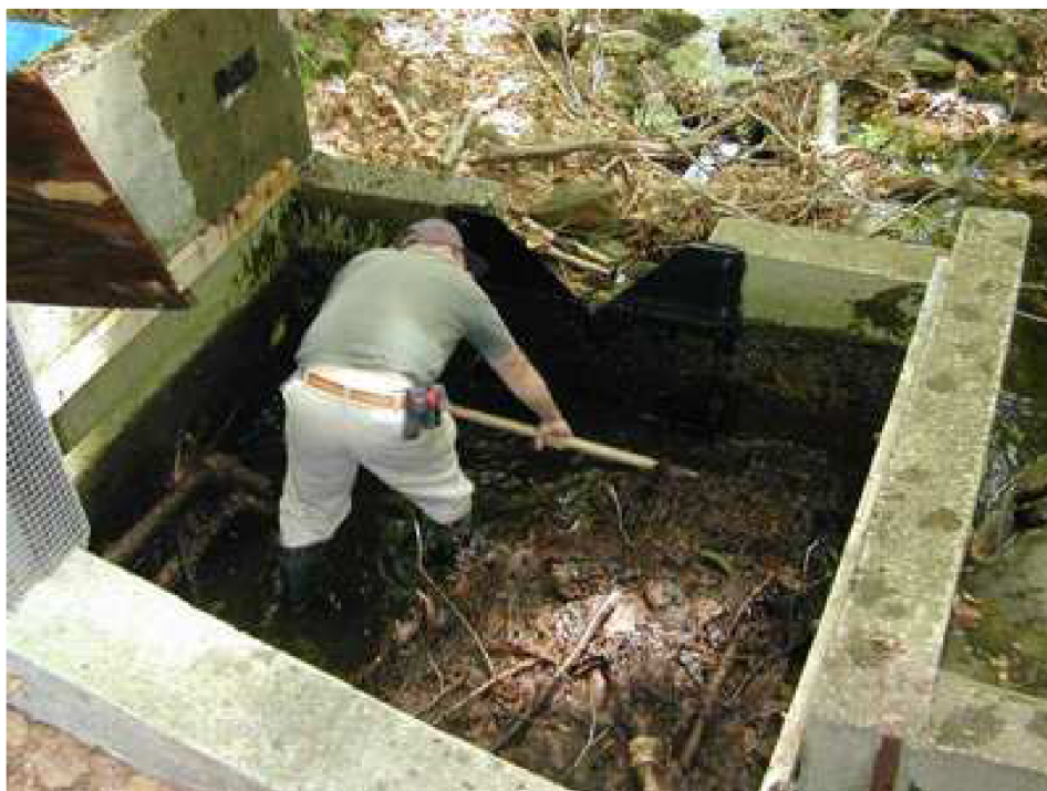
Obr. 3.2 Údržba návodního prostoru přelivu [7]
