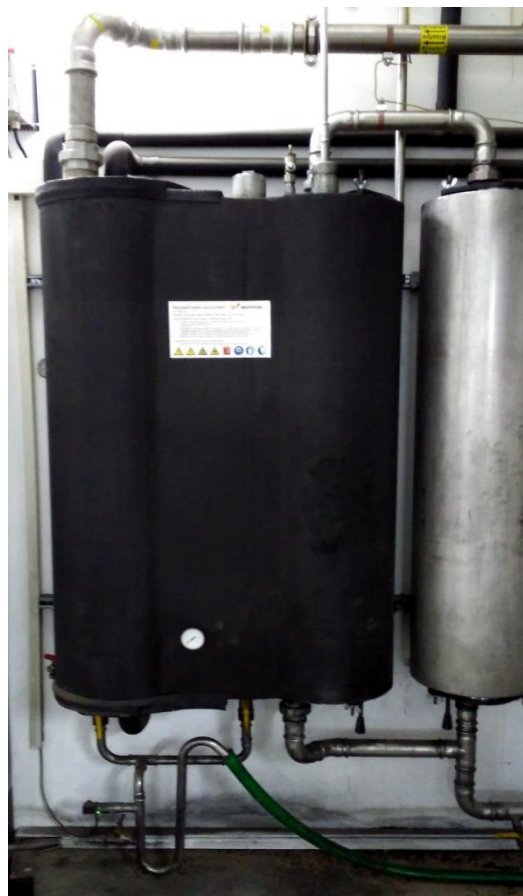
Obr. č. 12. Jednotka úpravy plynu GAM120-V3. Foto: autor.
