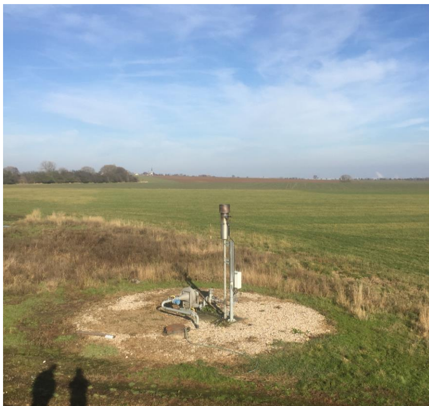
Obr. č. 16. Pojistný hořák HSB 150. Foto: autor.
