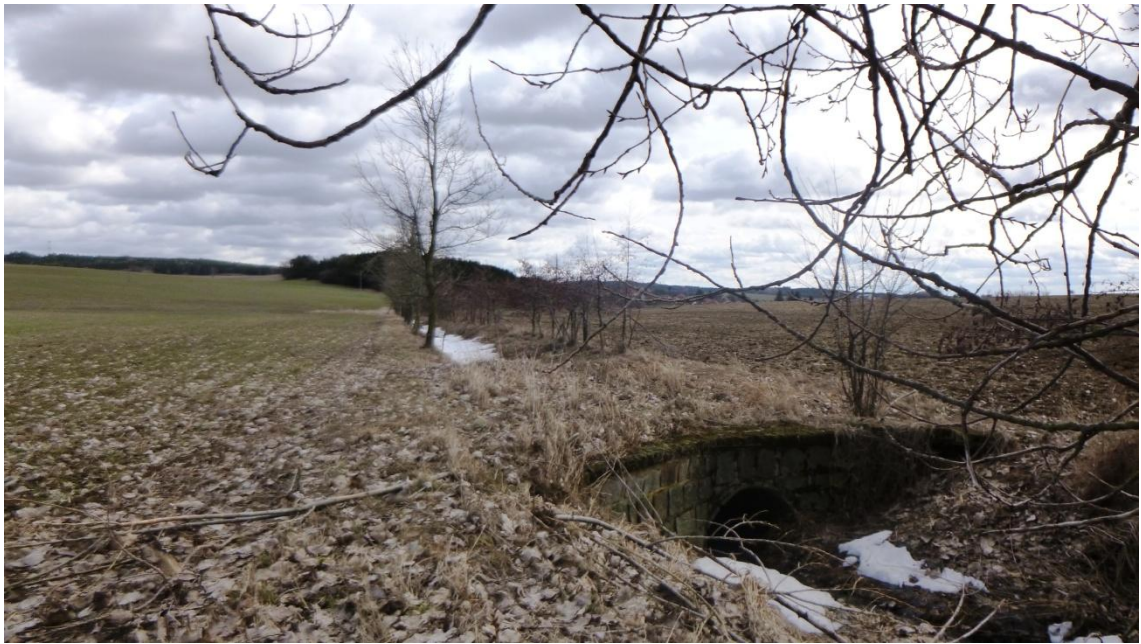
Obr. 13 - Propustek mezi poli
