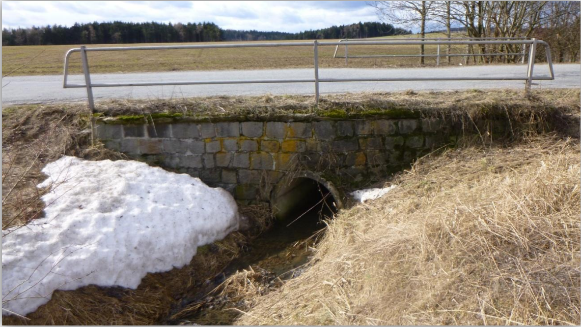
Obr. 4 - Propustek pod silnicí
