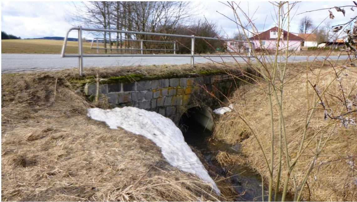
Obr. 15 - Propustek u silnice
