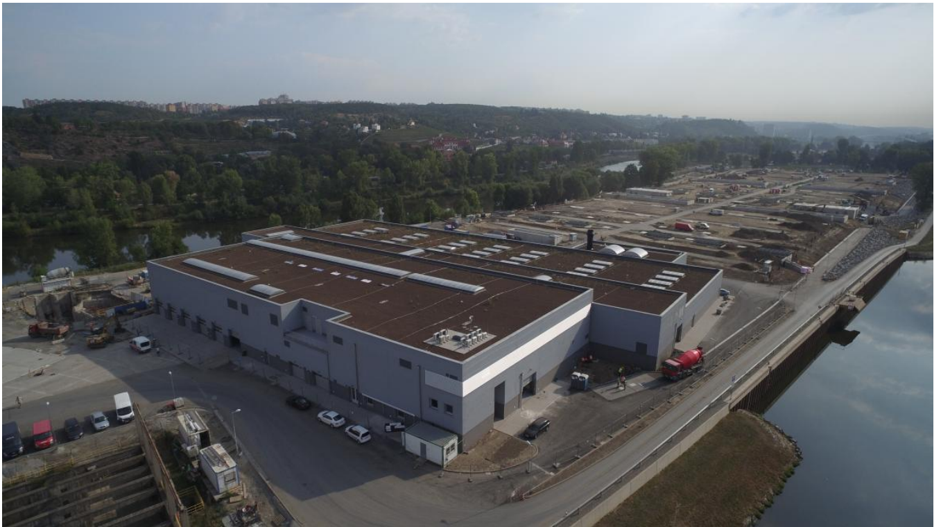
Obrázek č. 13, 14 – Nová vodní linka Ústřední čistírny odpadních vod na Císařském ostrově
