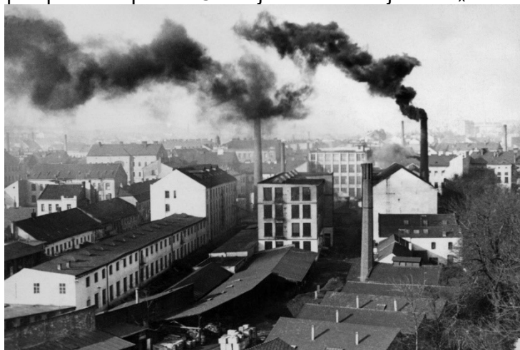
Obr. 17 odvod spalin do atmosféry, Teplárny Brno (Špitálka) 1930, první tuzemská teplárna s kogenerací elektřiny (zdroj: teplárny brno)
