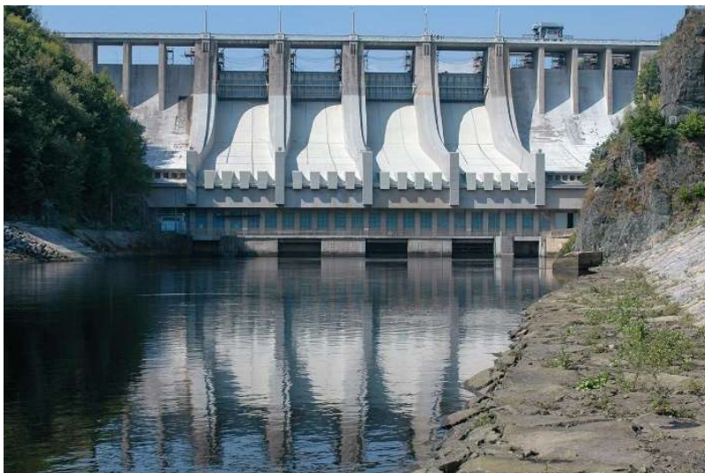
Obr.10 vodní elektrárna (zdroj: ČEZ)
