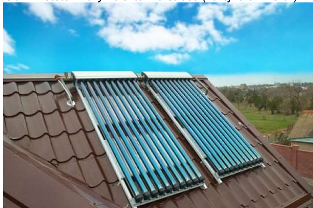
Obr.7 Fototermický kolektor na střeše (zdroj: cronimo.cz)
