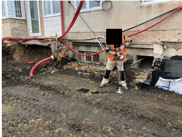
Obr. 1.16 – Kontrola hutnění kanalizace u výpravní budovy pod úrovní zemní pláň
