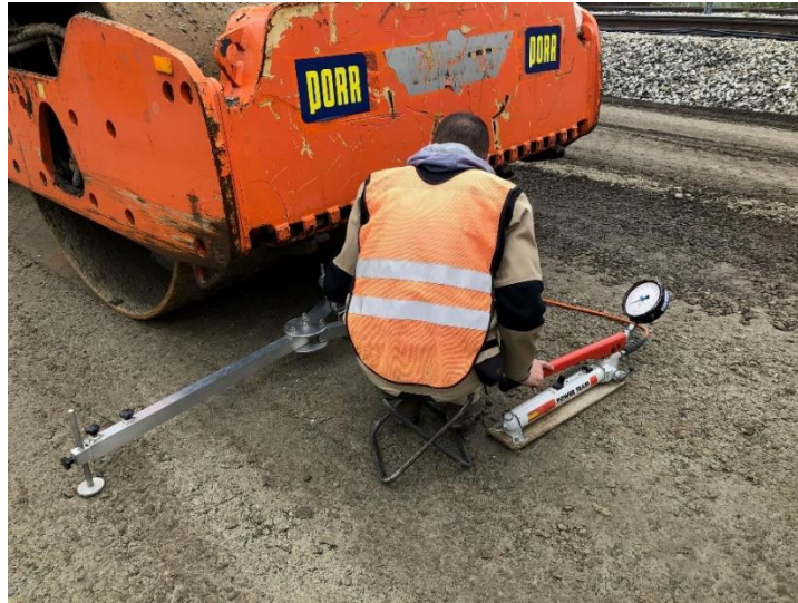
obr. 1.13 – SZZ prováděná na konstrukční vrstvě PTŽS ze štěrkodrti a geokompozitu
