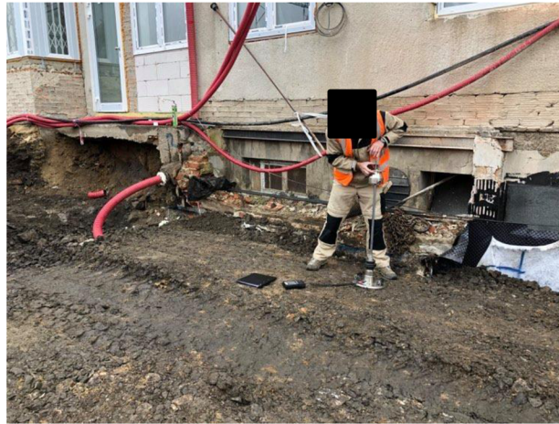
Obr. 1.16 – Kontrola hutnění kanalizace u výpravní budovy pod úrovní zemní pláně
