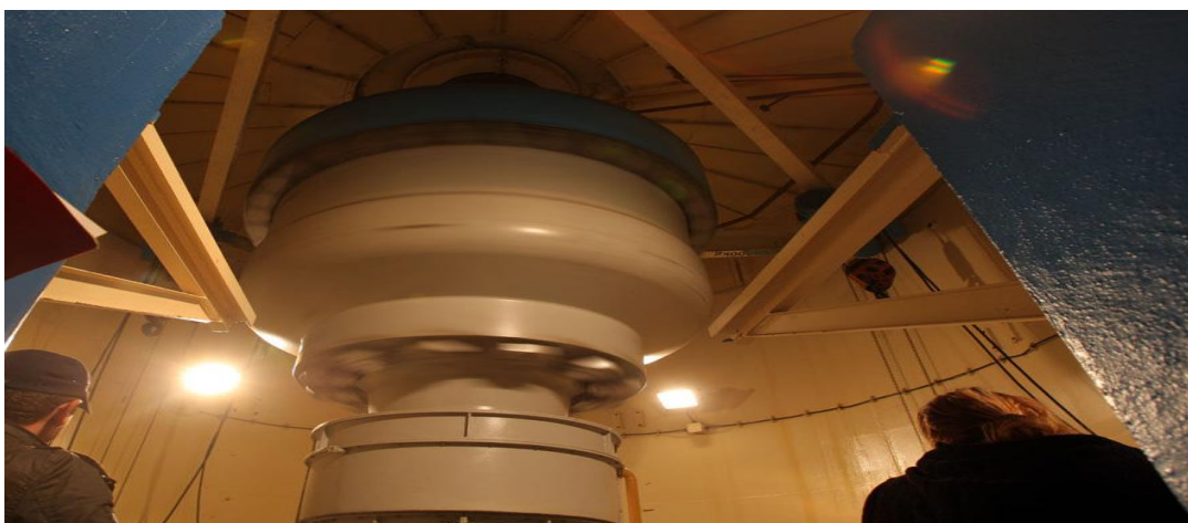
Obr. č. 4; Průměr kola turbíny 4,5 m (zdroj: http://zpravy.aktualne.cz )
