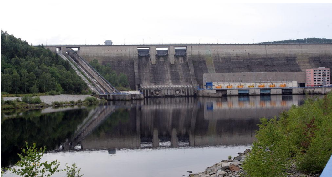
Obr. č. 1; Hráz přehrady Orlík. 81,5 metrů vysoká, 450 metrů široká. Více než milion kubiků betonu (zdroj: http://zpravy.aktualne.cz )
