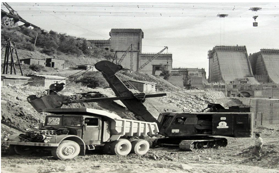
Obr. č. 2; Výstavba hráze Orlické přehrady 1954 (zdroj: http://zpravy.aktualne.cz )
