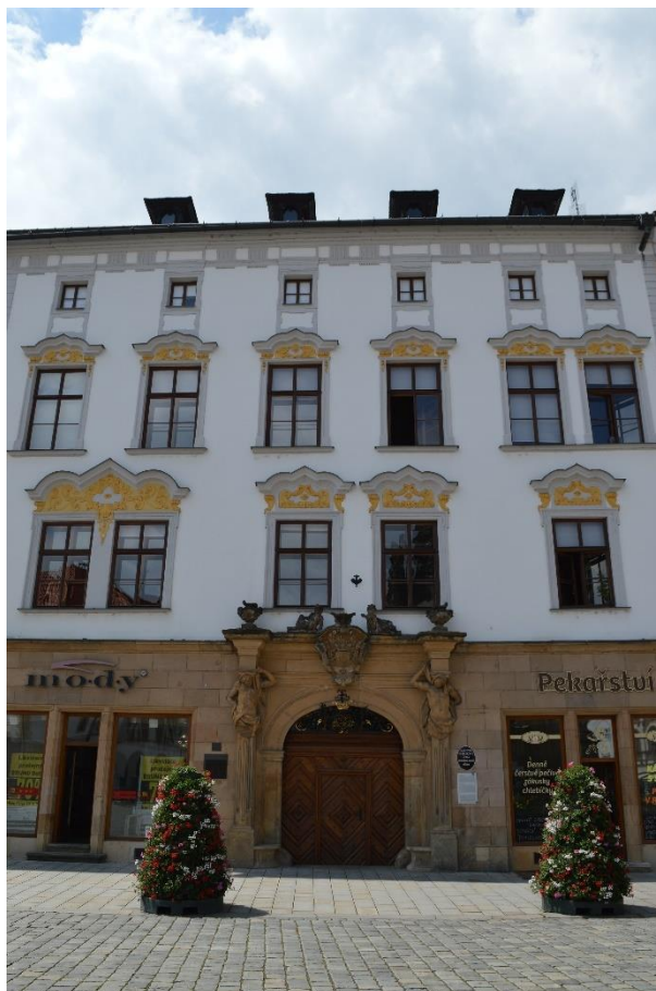
Obrázek 8-průčelí Petrášova paláce z Horního náměstí
