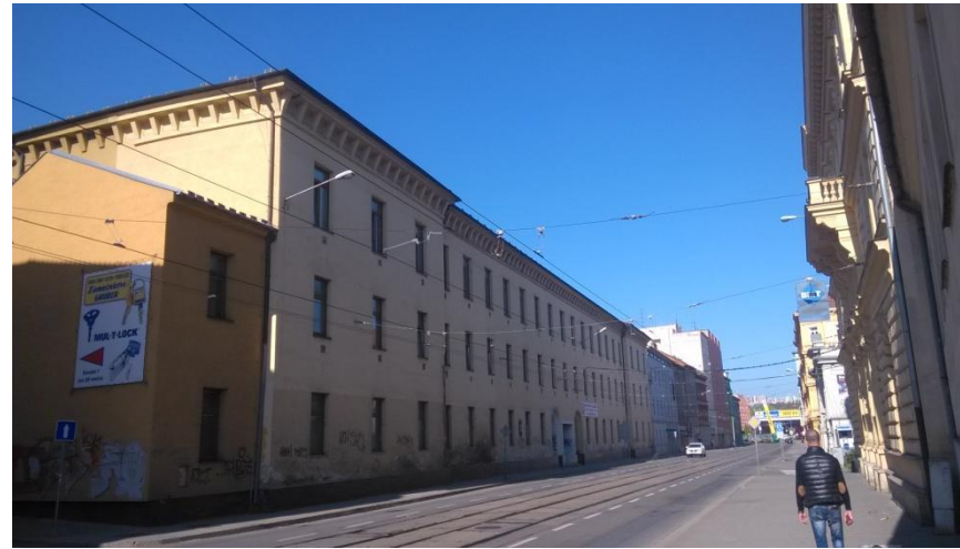
OBR. 36 Jižní křídlo káznice, ulice Cejl
