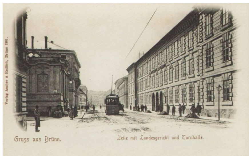
OBR. 35 POHLED NA CEJL A BUDOVU KÁZNICE Z ROKU 1901
