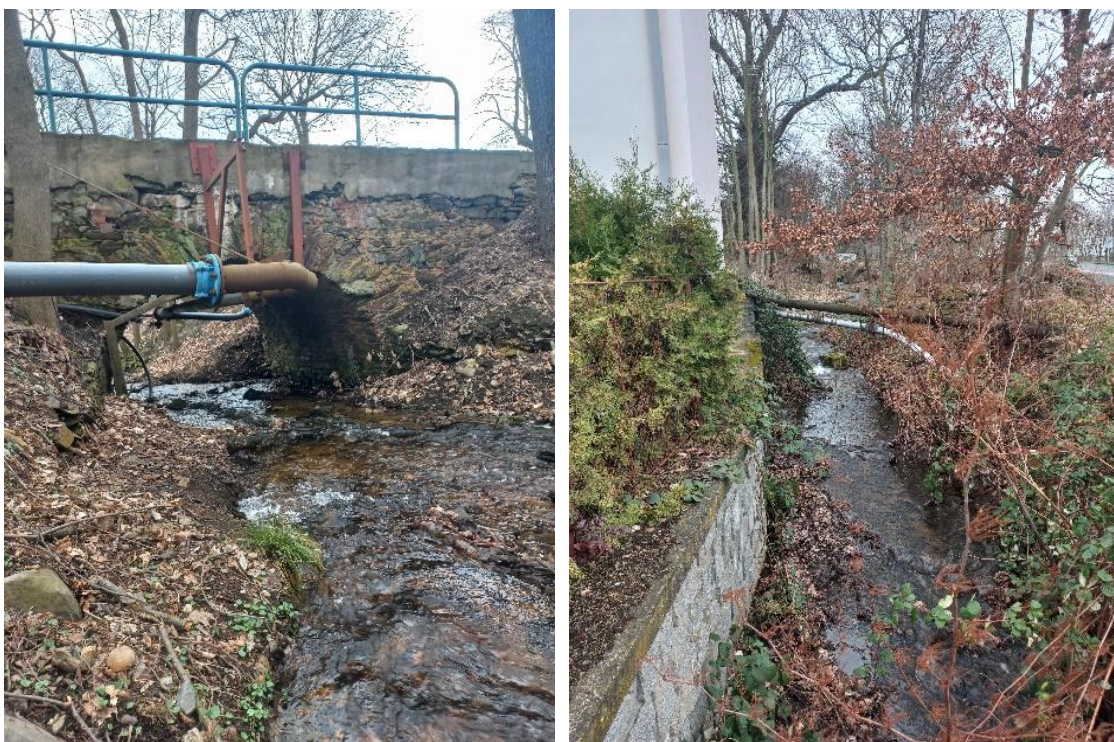
Obrázek (č.10) – Most vedený přes tok Lužec
