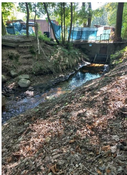
Obrázek (č.12) – bariévní malá hráz (viz. Př. č.16)
