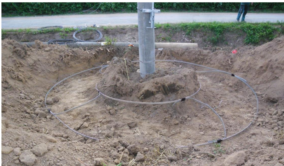
Obr. 8-1 Uzemnění úsekového odpínače pomocí dvou ekvipotenciálních kruhů
