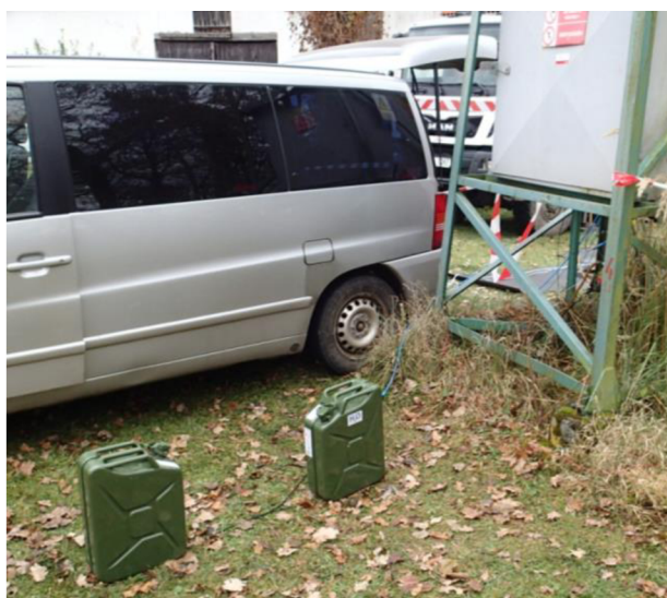
Obr. 9-10 Měření krokového napětí v blízkosti postižené DTS
