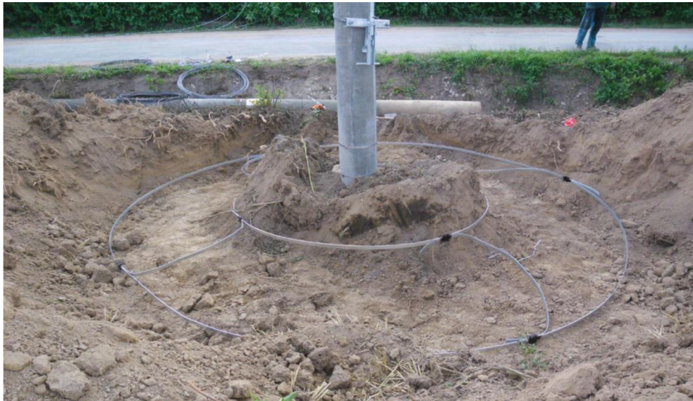
Obr. 8-1 Uzemnění úsekového odpínače pomocí dvou ekvipotenciálních kruhů
