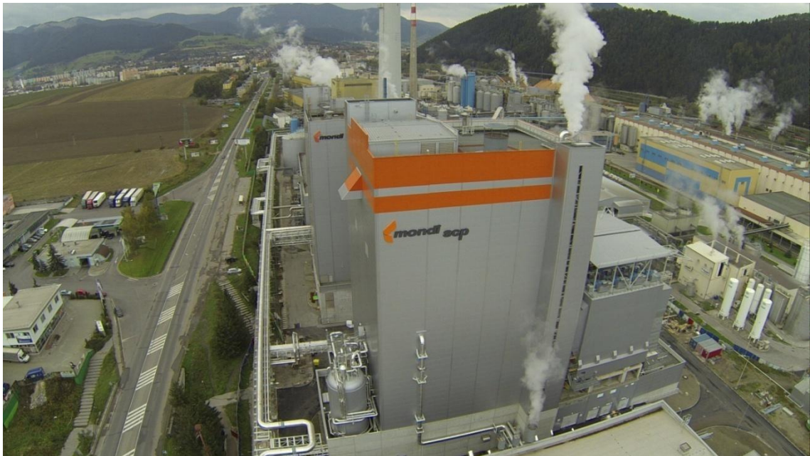
Detail na novovybudovaný kotol z investičnej činnosti RK3
