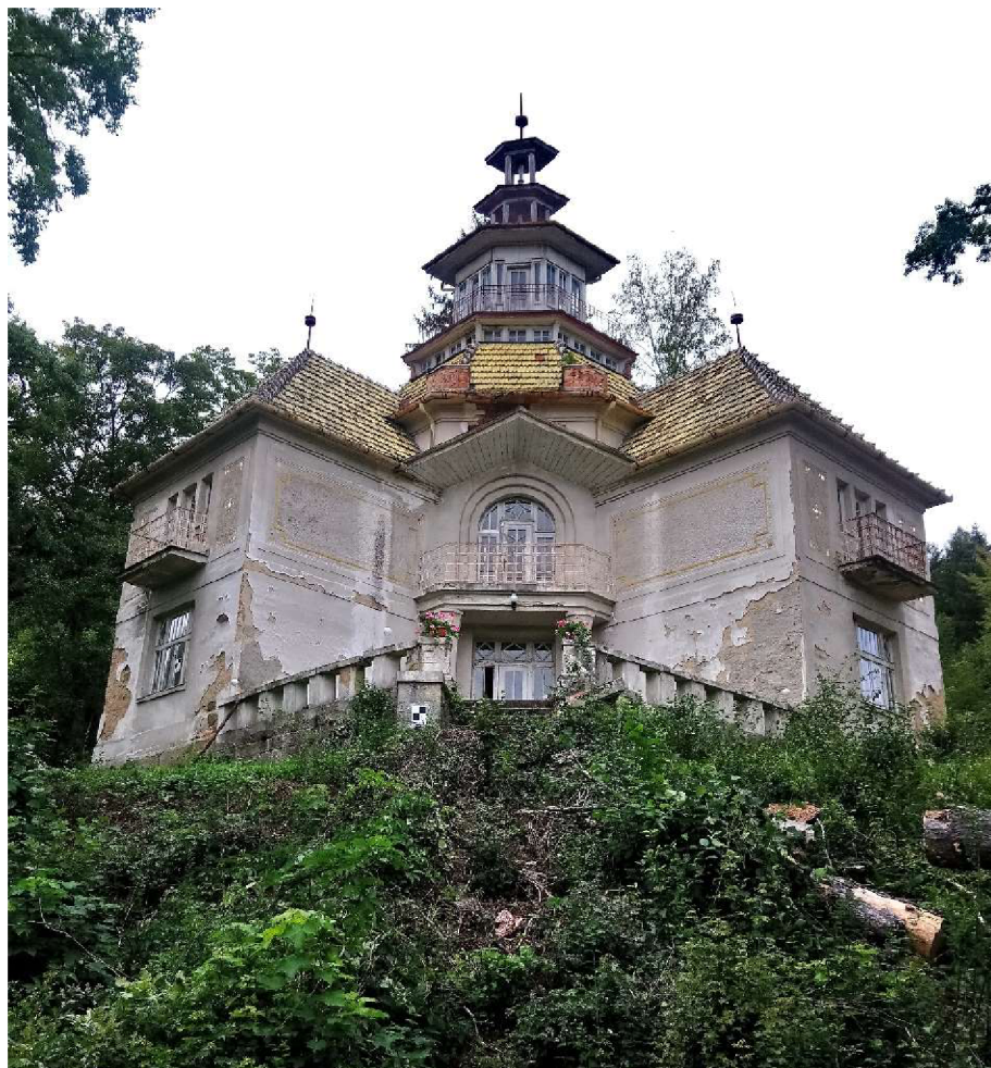
Obr. č. 7: Pohled na současný stav objektu od vstupní strany [foto: Ing. Hovorka]
