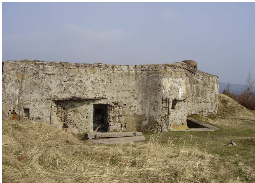
Obrázek 5: Dopadová plocha Tok – pěchotní srub, foto: Ungrová Ilona, 2013
