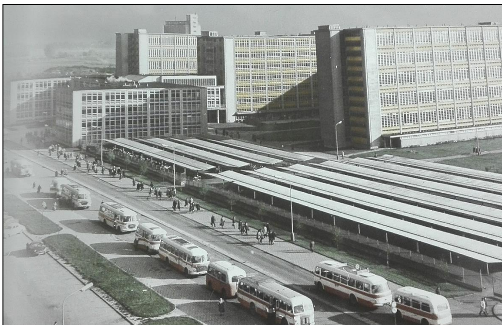
Obr. 12 Textilní komplex OP Prostějov postavený v roce 1965
