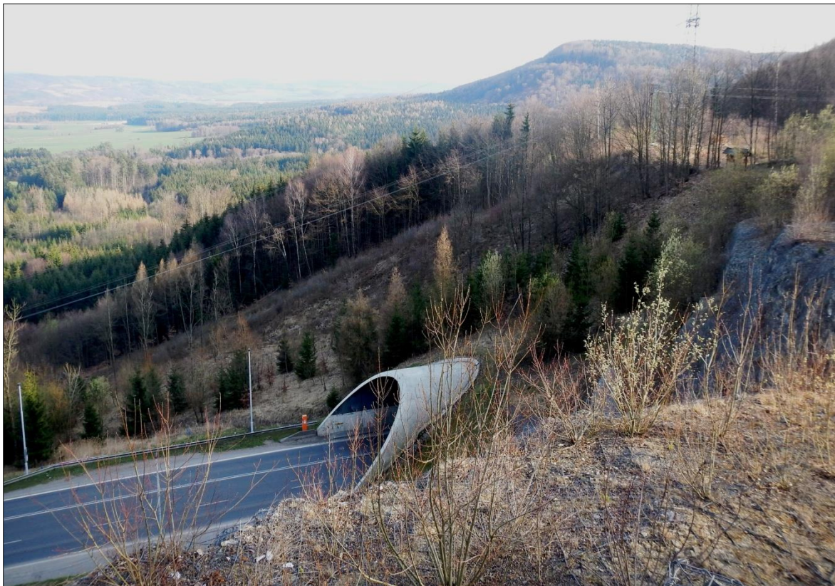
Obr. 34 Silniční tunel Hřebeč (foto: I. Voleská, 2016)
