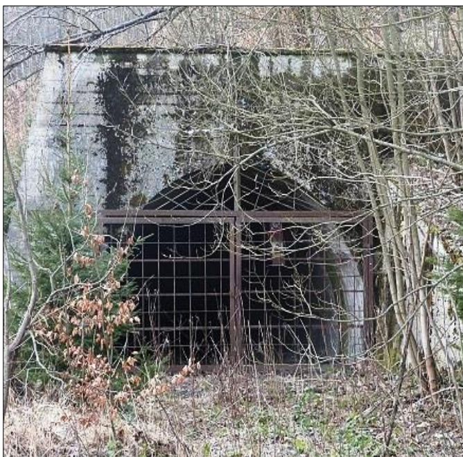
Obr. 32 Jihlavská štola (foto: I. Voleská, 2016)
