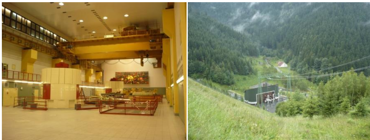
Obr. 18: Část kaverny vyražené ve skalním masivu a zapouzdřená rozvodna 400 kV (Zdroj: fotografie autora).
