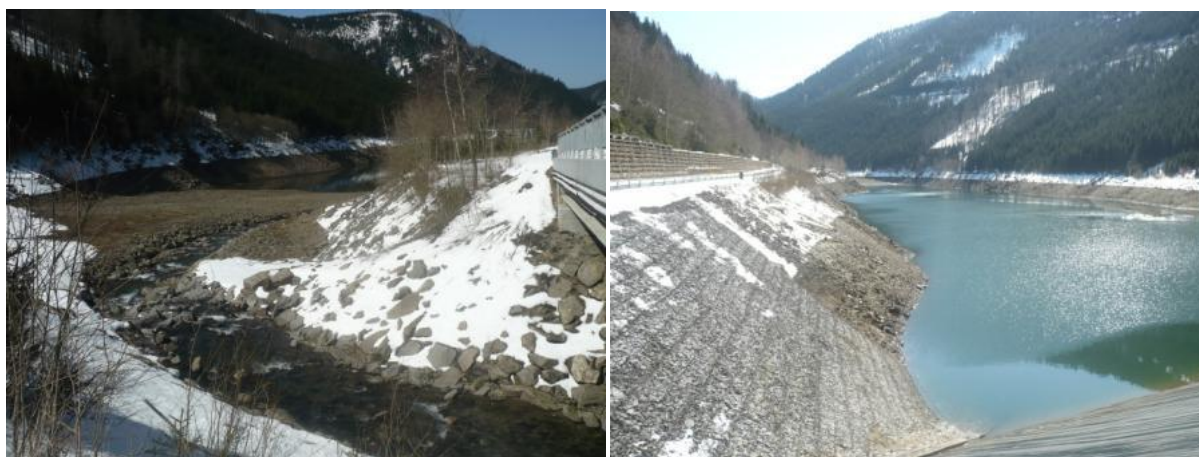
Obr. 20: Přítok Divoké Desné do dolní nádrže v místě horního vzduť a dolní nádrž se znatelným pásem absence života (Zdroj: fotografie autora).
