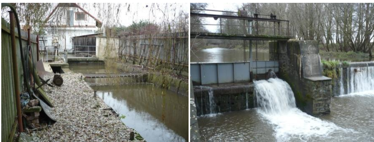
Obr. 12: Budova elektrárny včetně hrubých česlí a jez zásobující vodou derivační kanál
