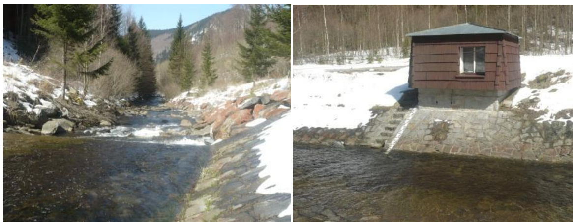
Obr. 22: Vodoměrná stanice na Divoké Desné pod PVE a koryto řeky pod elektrárnou (Zdroj: fotografie autora).
