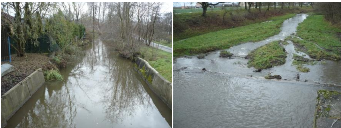
Obr. 14: Derivační kanál k MVE a koryto řeky pod jezem (Zdroj: fotografie autora).
