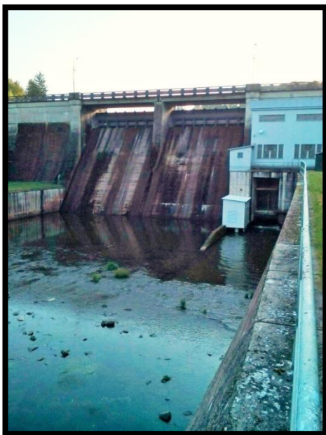
Obr.12. Hráz Křižanovické přehrady (vlastní foto)
