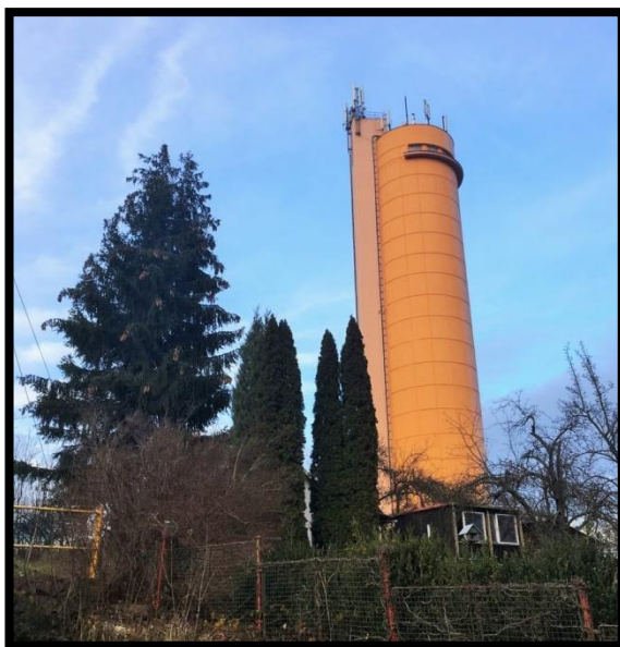
Obr.14. Vodárenská věž Práčovské přehrady (vlastní foto)
