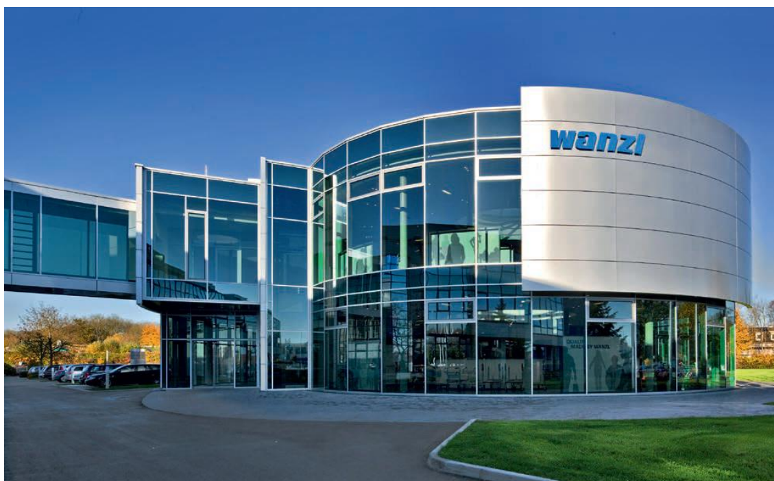
Obr. 1 – Budova firmy. Zdroj: Wanzl Zpravodaj, Firemní časopis pro zaměstnance firmy , s. 3.
