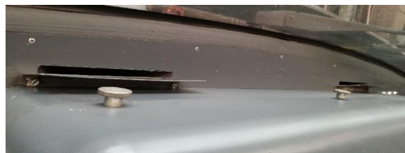
Obr. 7 - Průduchy od ventilace a topení
