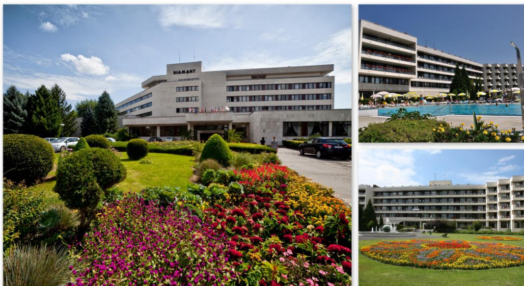
Obr. 4 Vzhľad budovy LÚ Diamant Zdroj: Interný zdroj LÚ Diamant
