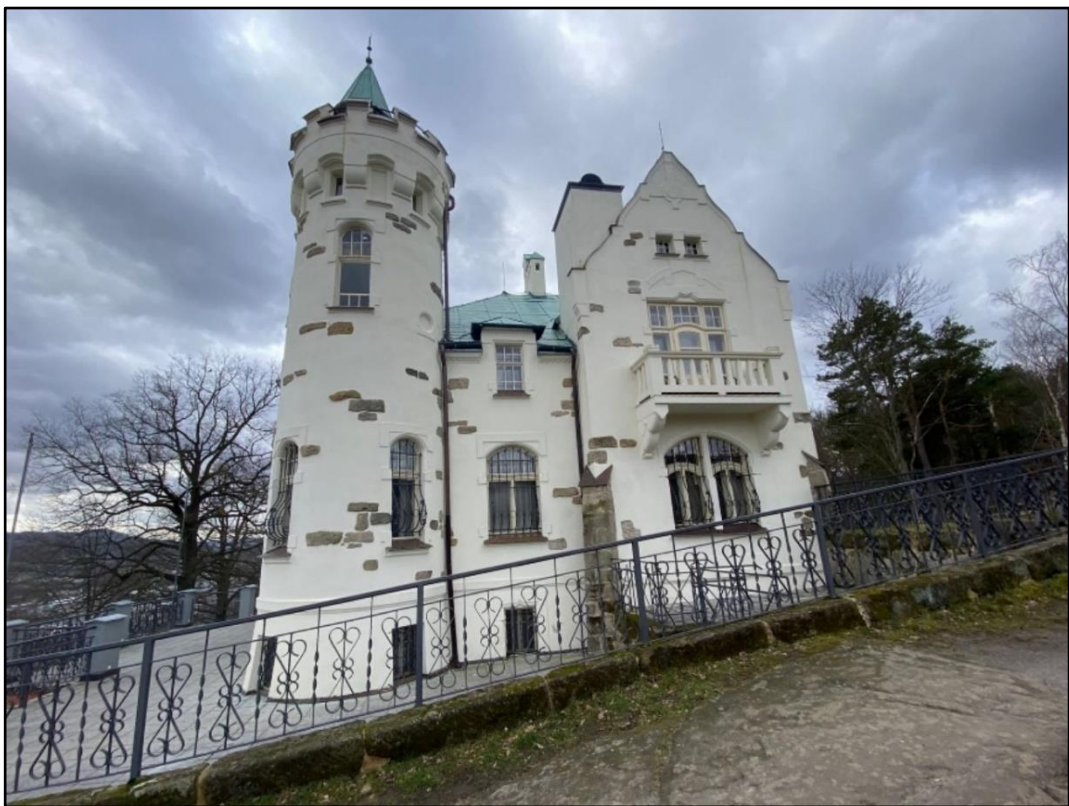
Foto č. 27. NS Pastýřská stěna – restaurace na Pastýřské stěně.
