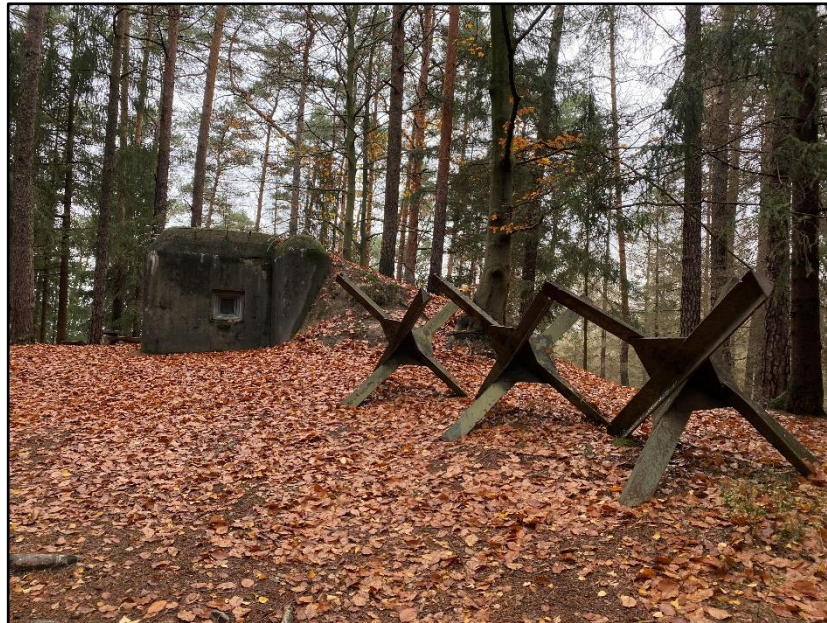
Foto č. 7. NS Růžová – bunkr se železnými překážkami u zastavení č. 3.
