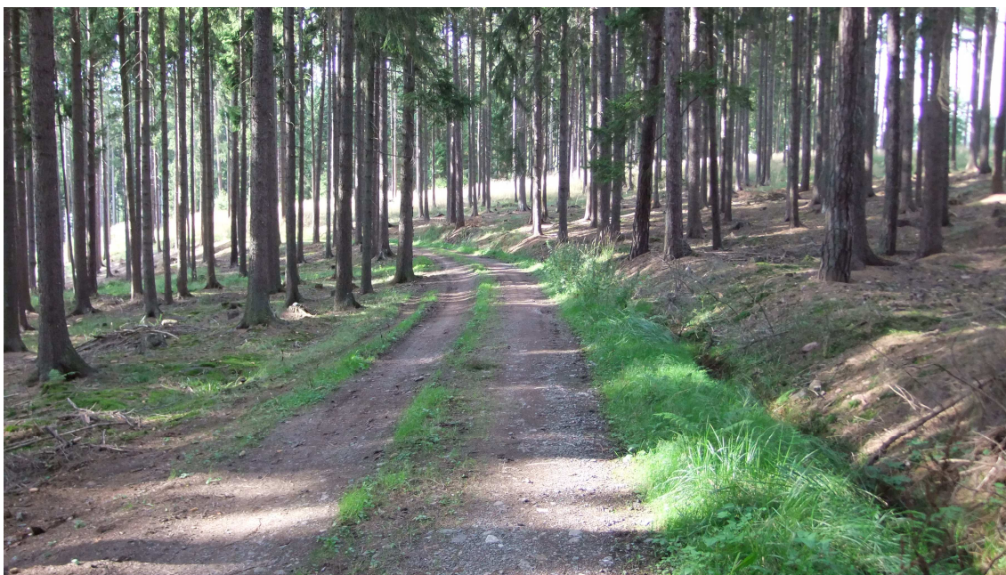
Lesní cesta třídy 2L 2 – 50K, část „Krymlov“ (koruna cesty se zemním povrchem)
